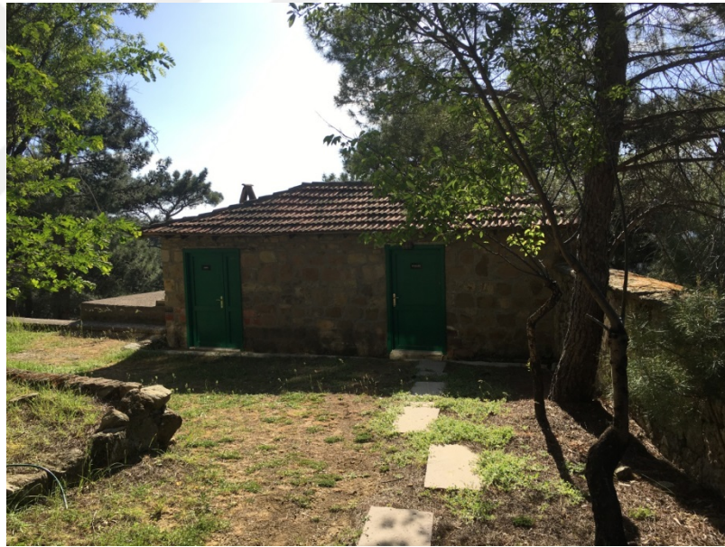
Şekil 4. 13 : Adatepe İlkokulu tuvalet binası (M. Çakıloğlu, 2019)
