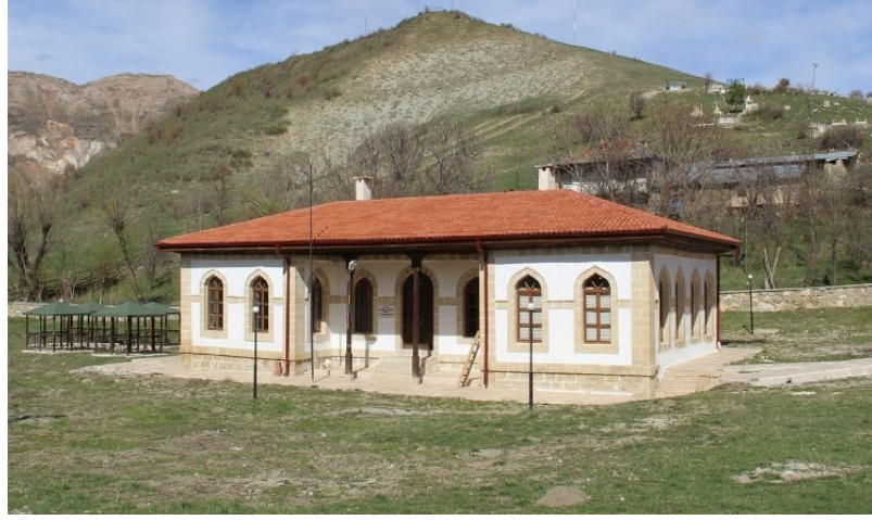
Şekil 2. 8 : Sivas Karacaören Köyü İlkokul Binası (”Sivas’ta 113 yıllık tarihi mektep”, 2019)
