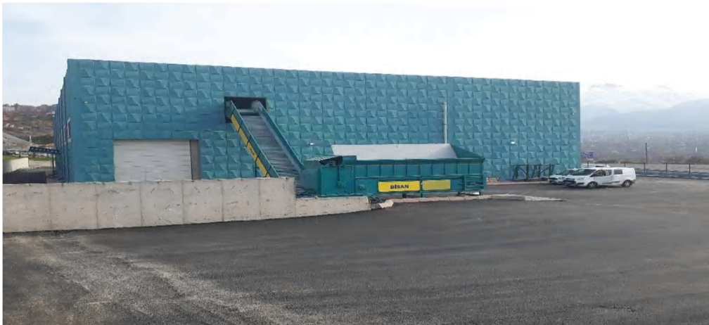
Şekil 1.14. Melikgazi Belediyesi TAT Tesisi 20 m 3 Kapasiteli Poşet Açıcı Bölümü
