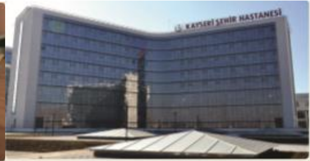
Şekil 22. Kayseri Şehir Hastanesi
