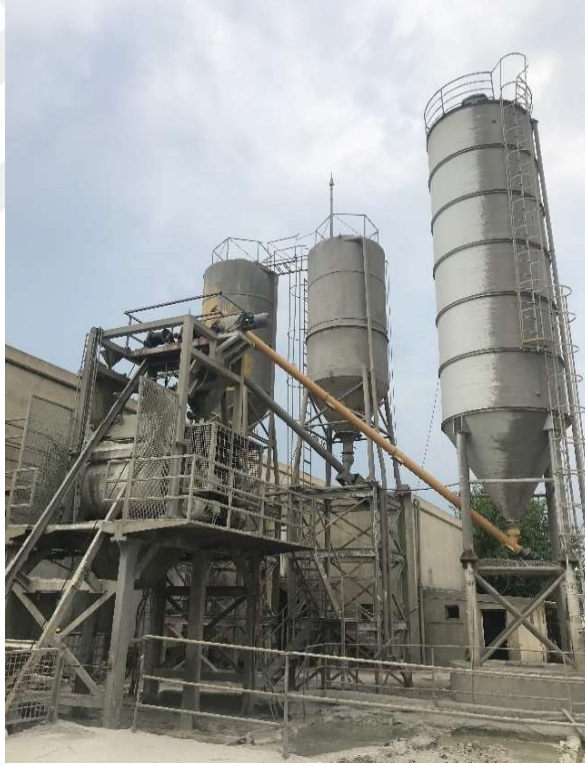
Şekil 4.3 Batı prefabrik A.Ş. firmasına ait beton karışımlarının yapıldığı beton santrali (Kişisel arşiv, 2017)
