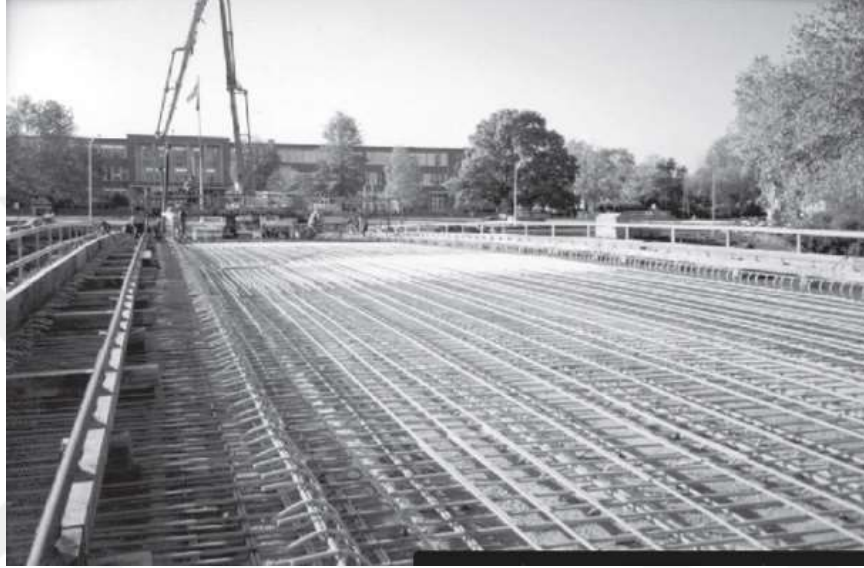
Şekil 2.3 FRP ile döşeme güçlendirme inşaatı Lima,OH (Pierce st. brige,'99) (ACI-440.1R-15, 2015)
