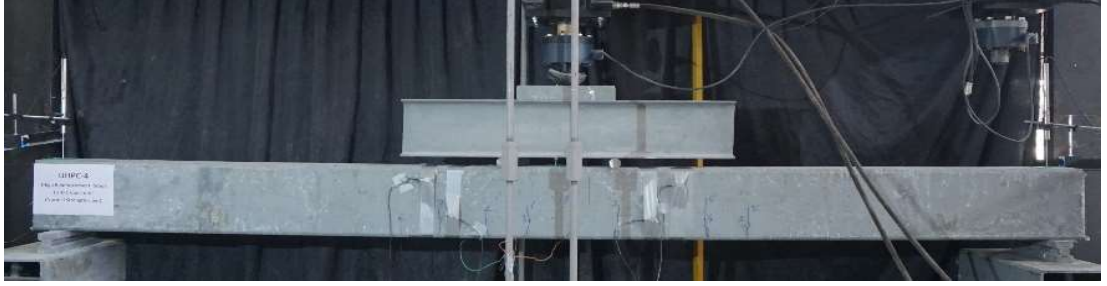
Şekil 5.9 Kiriş-2 üzerindeki ilk çatlakların oluşumları (Kişisel arşiv, 2017)
