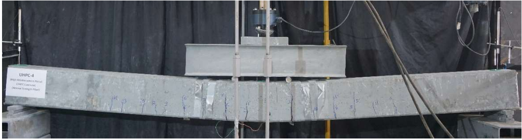
Şekil 5.10 Kiriş-2 üzerindeki 11-14 nolu çatlakların oluşumları (Kişisel arşiv, 2017)
