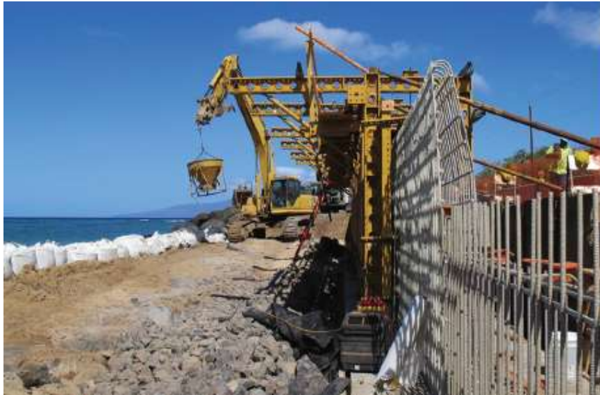
Şekil 2.4 GFRP ile dalgakıran inşaatı (ACI-440.1R-15, 2015)
