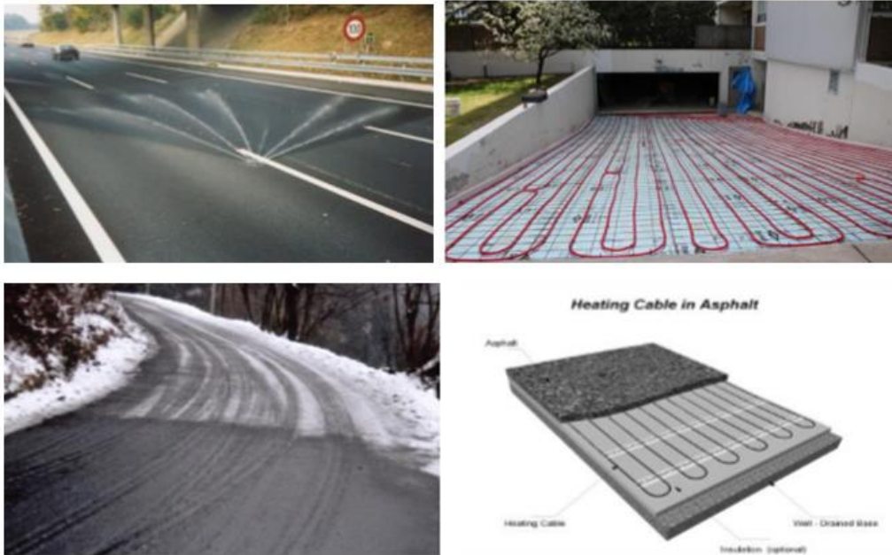
Resim 2.9 Kar ve buzlanma ile aktif mücadele yöntemleri: a) solüsyon püskürtme sistemleri b) donmayan asfalt karışımlar c) hidronik buz eritme sistemleri d) elektrik kablolarıyla buz eritme sistemleri (Gürer 2014).
