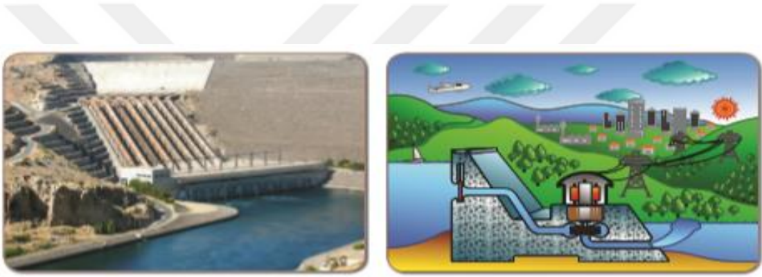
Görsel 242: MEB. (2019). 8. Sınıf. s:246'da hidroelektrik santrallerine ait görsellere yer verilmiştir.
