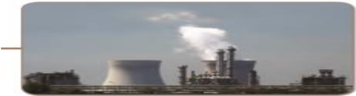
Görsel 243: MEB. (2019). 8. Sınıf. s:246'da termik santraline ait bir görsel yer verilmiştir.
