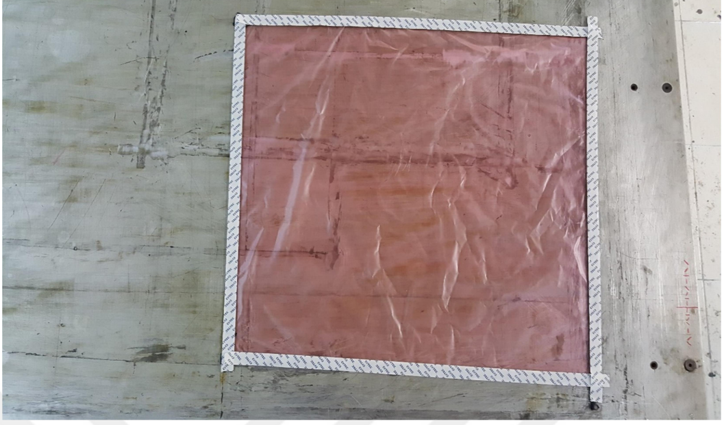
Şekil 2.5 Kalıp ayırıcı torbanın serilişi ve sızdırmazlık macununun uygulanması (Kişisel arşiv, 2019)
