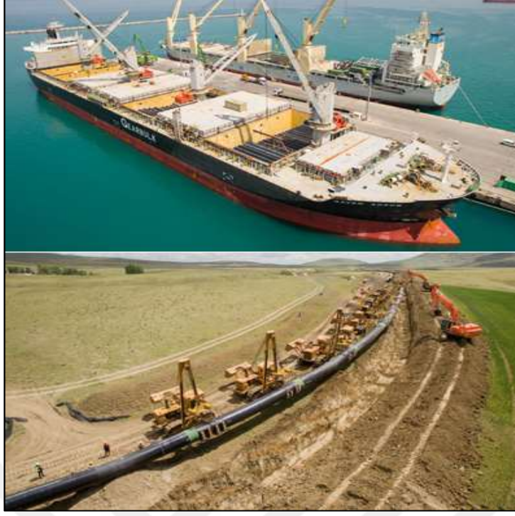
Şekil 2.2: Günümüzde boru hattı inşaatı [27].
