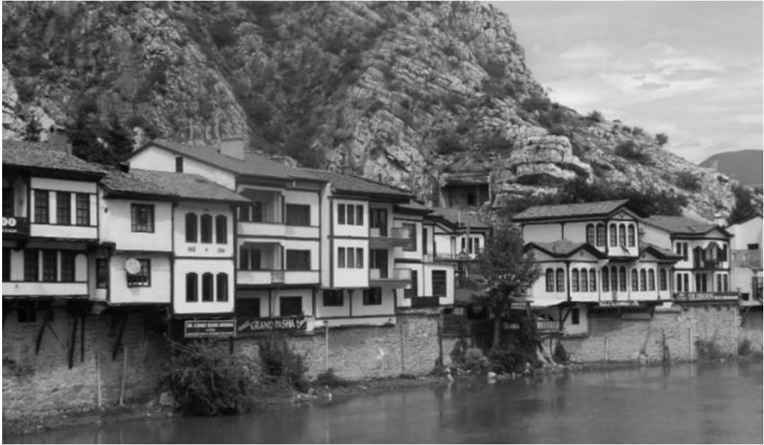
Şekil 6.5 : Sur duvarı üzerine oturan Yalıboyu evleri.
