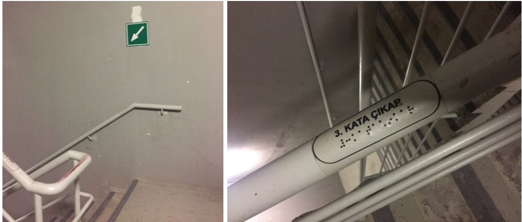
Şekil 5.19: Acil kaçış merdiveninde yapılan yönlendirmeler.
