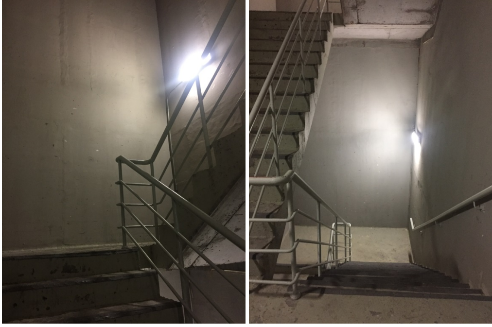
Şekil 5.18: Acil kaçış merdiveninde duvara monte edilen simetrik noktasak kaynak.
