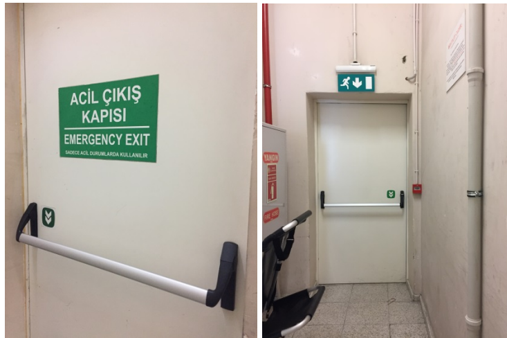
Şekil 5.21: Tip 2 AVM'deki acil çıkış kapısı üzerindeki armatür yerleşimi.
