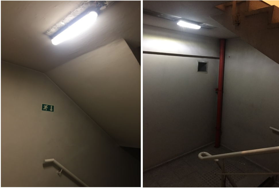
Şekil 5.24: Acil kaçış merdiveninde merkez çizgi üzerinde tavana monte edilen simetrik noktasal kaynak.
