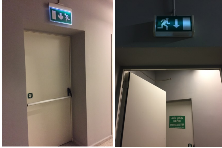
Şekil 5.22: Tip 2 AVM'deki acil çıkış kapısı üzerindeki armatür yerleşimi ve içten aydınlatmalı yönlendirme işaretleri.
