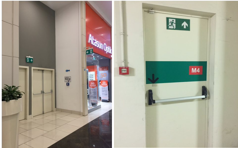
Şekil 5.26: Tip 3 AVM içerisindeki acil çıkış kapıları üzerindeki yönlendirme işaretleri ve piktogramlar.
