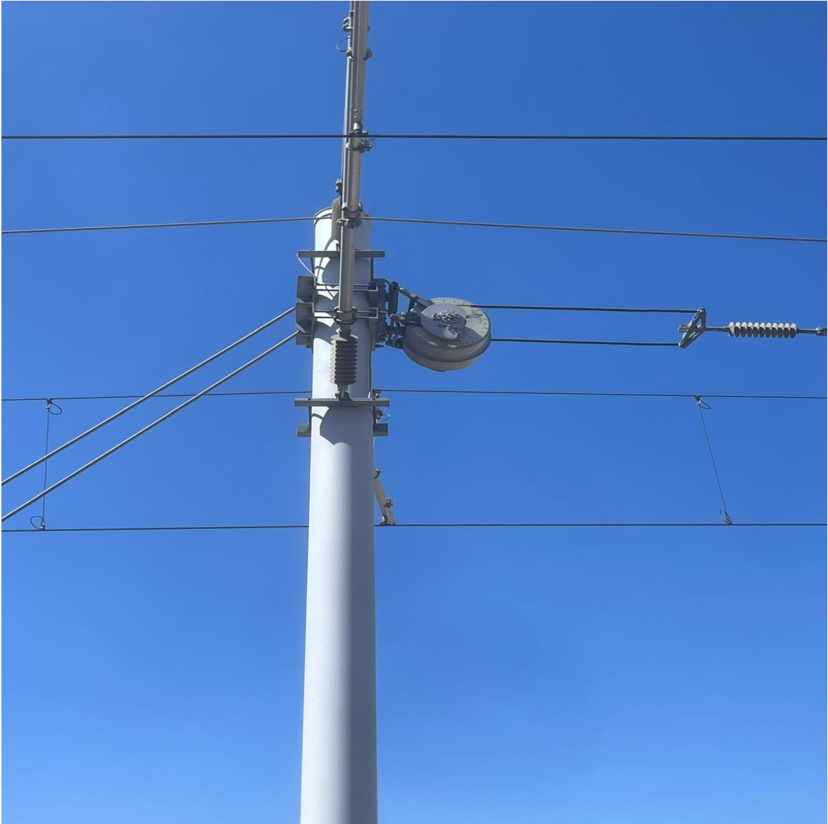
Şekil 3.5 Yaylı otomatik gergi cihazı seti
