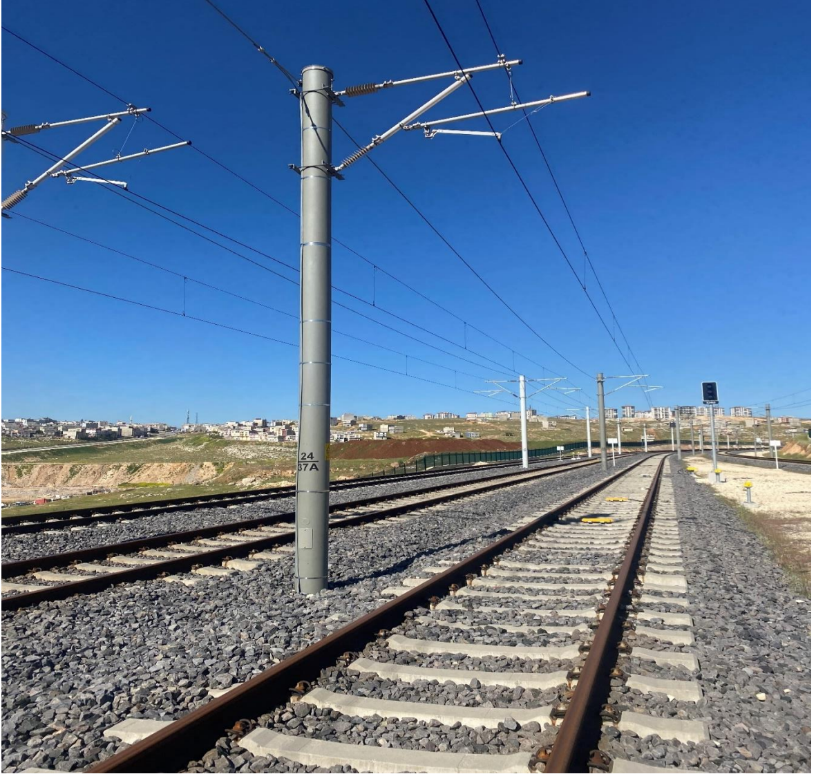
Şekil 3.1 Tek konsol taşıyan a tipi demir direk
