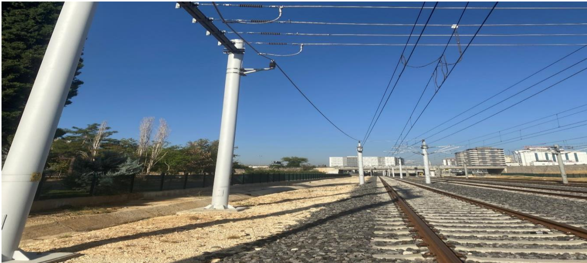
Şekil 3.7 Fider iletkeni
