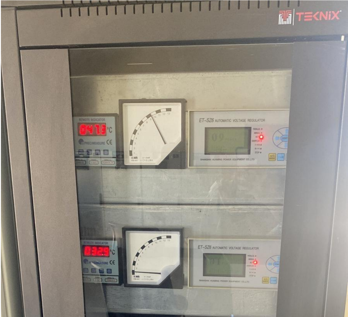
Őekil 3.17 Yk altında otomatik kademe deęiřtiricisi
