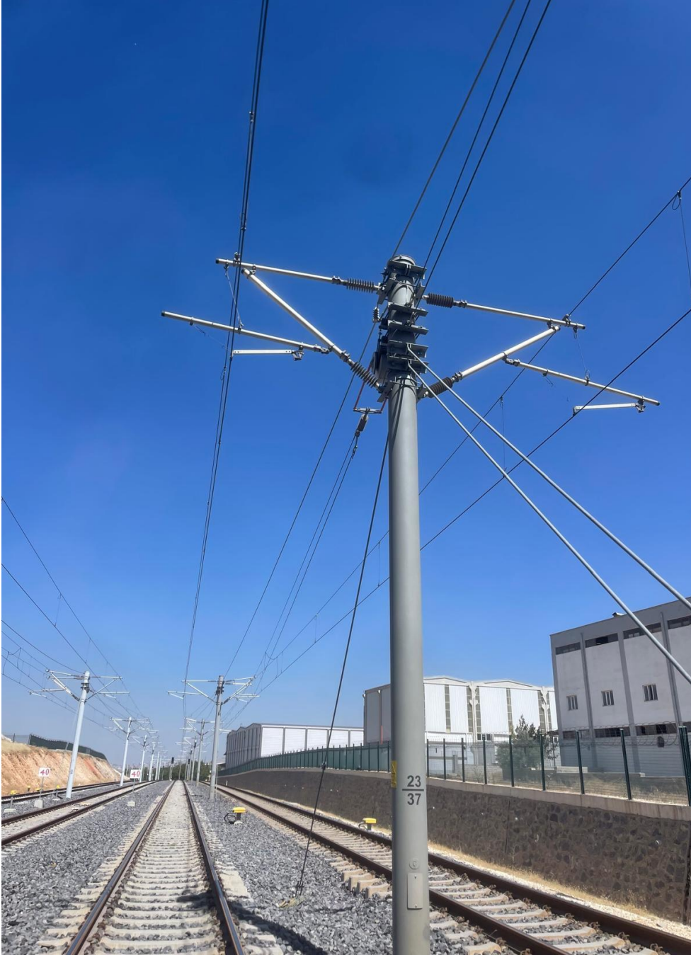
Şekil 3.2 Şemsiye tipi konsol hoban takımı
