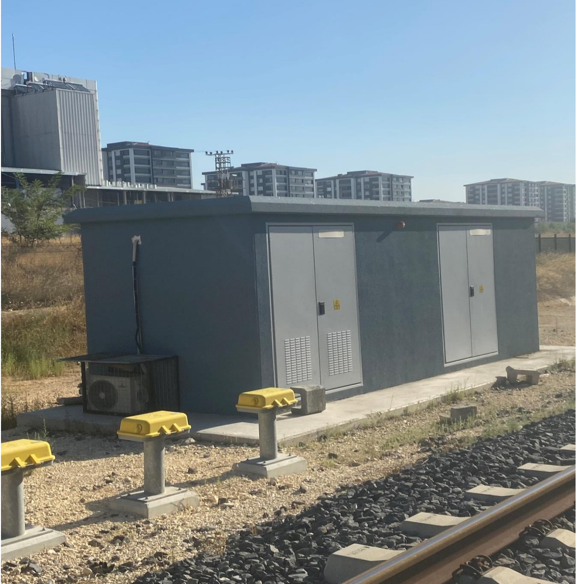
Şekil 3.12 Cer posta binası
