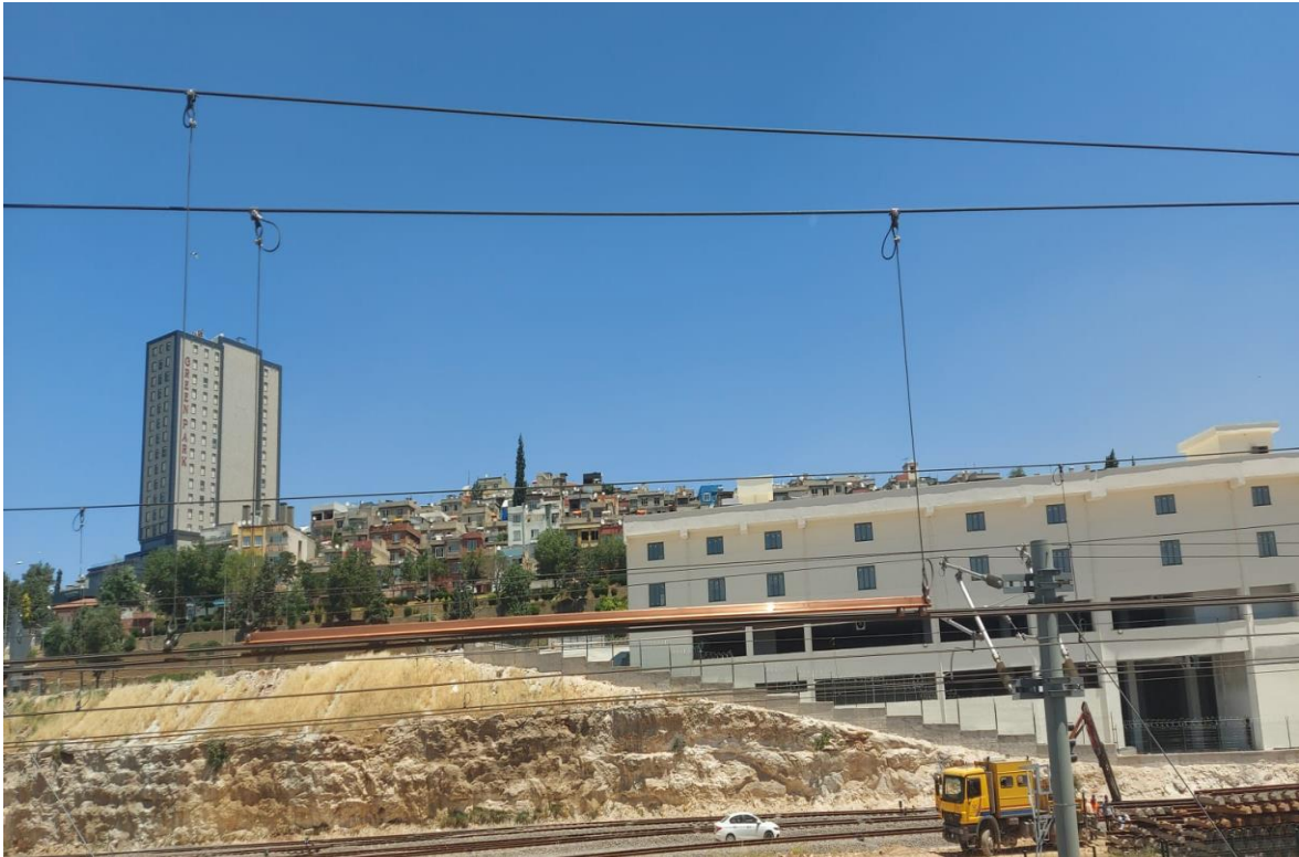
Şekil 3.16 Kruvazman çubuğu
