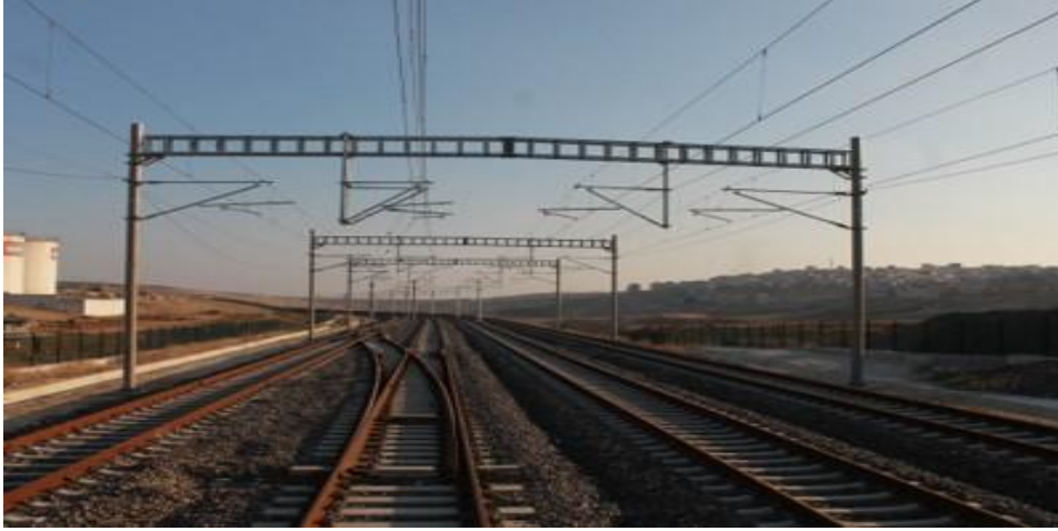
Şekil 2.3 Portik rijit katener sistemi
