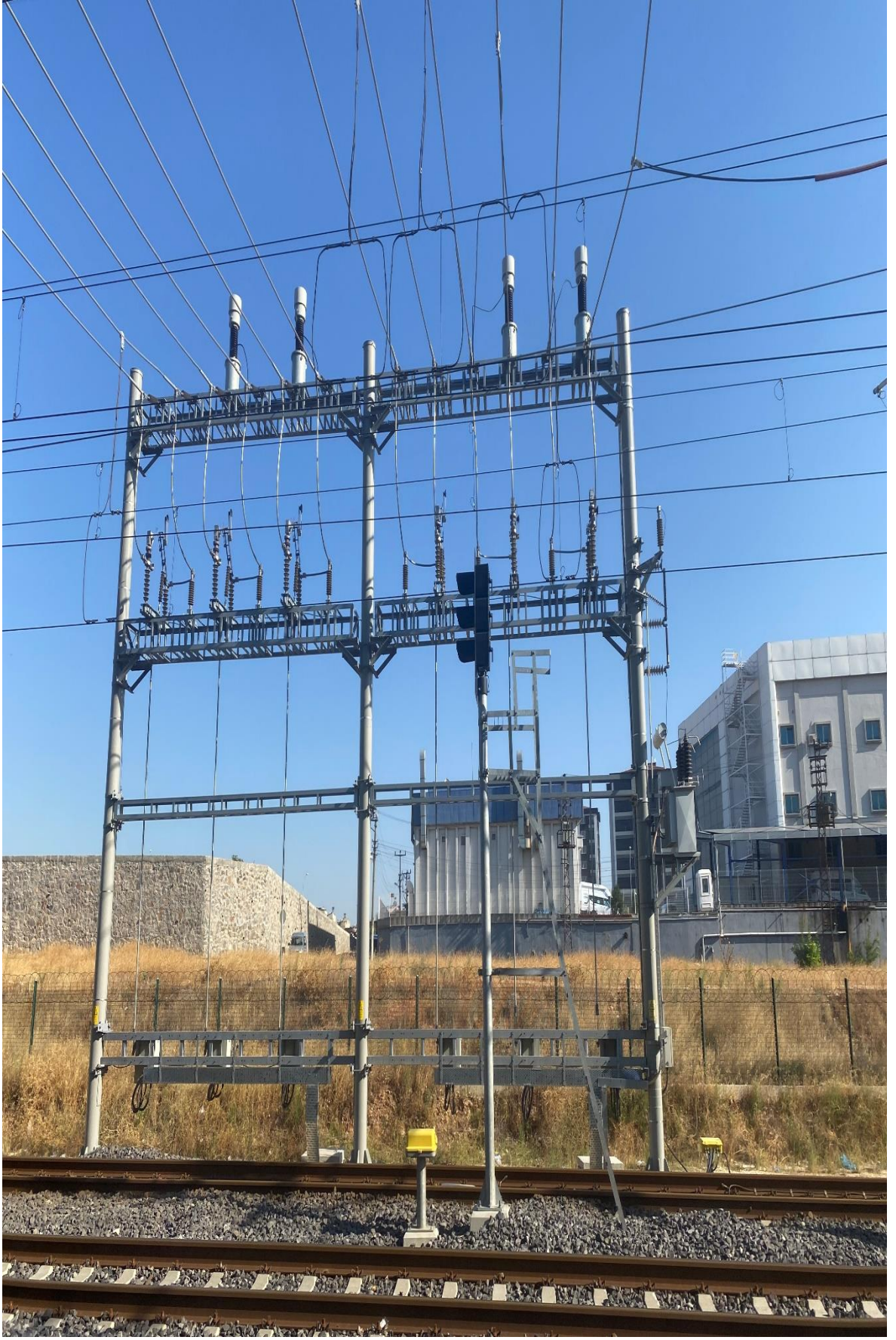
Şekil 3.13 Hertz portalı ve cihazları
