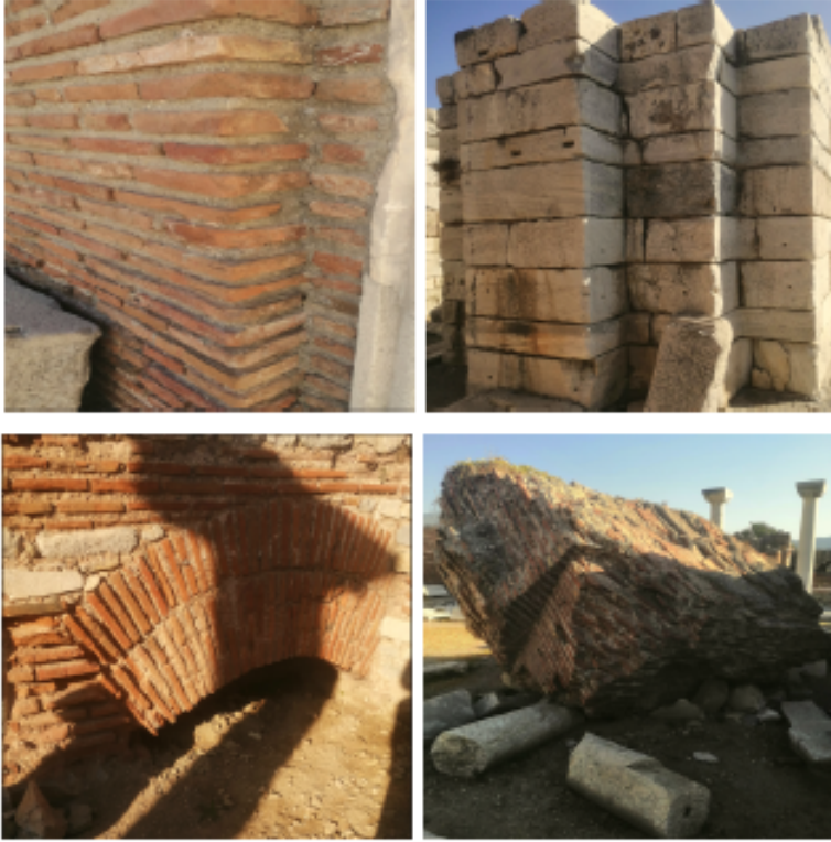
Şekil 4.6: St.Jean Bazilikasına ait taşıyıcı sistemlerin malzeme detayları
