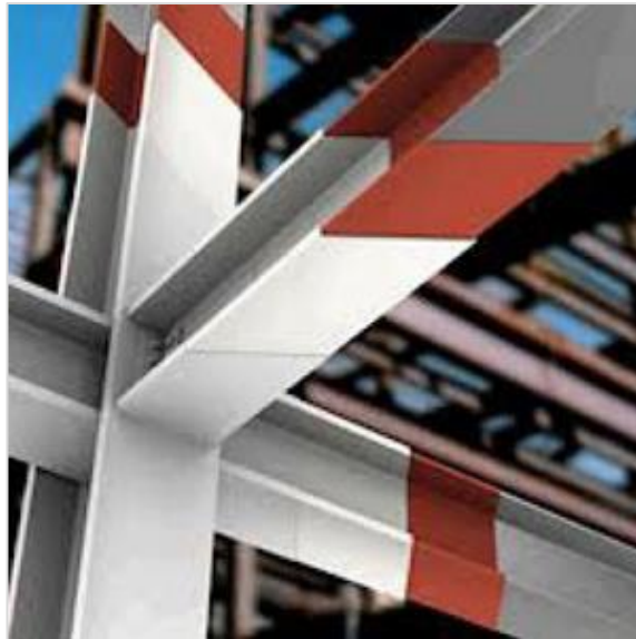
Şekil 1.2. İntümesan boya uygulaması
