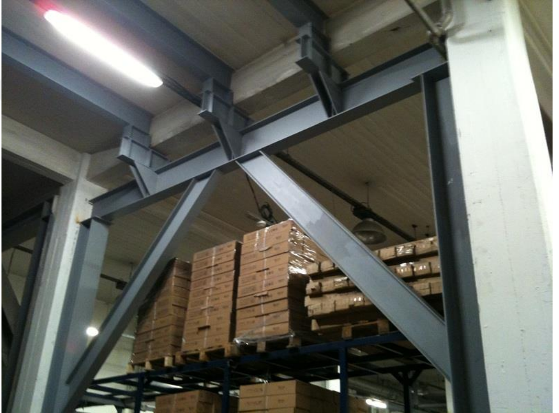
Şekil 1.6. Kaynaklı birleşimler
