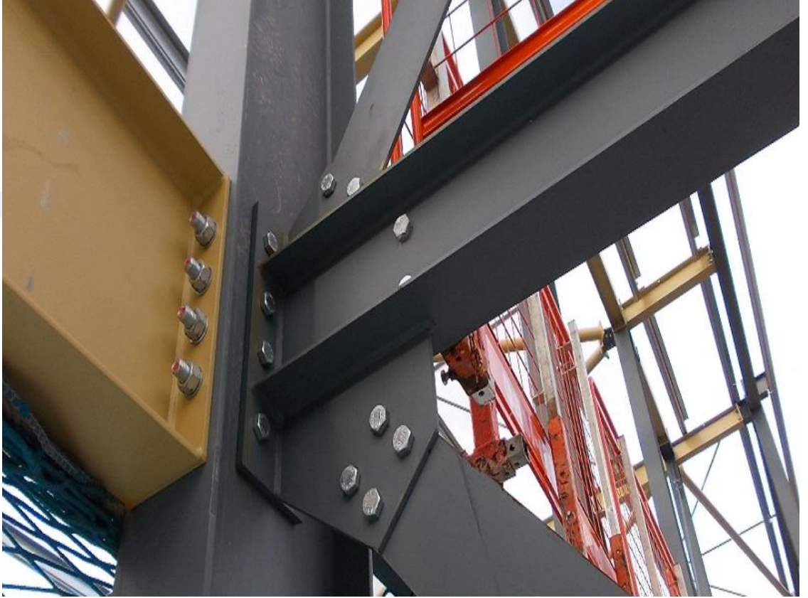
Şekil 1.5. Bulonlu birleşimler
