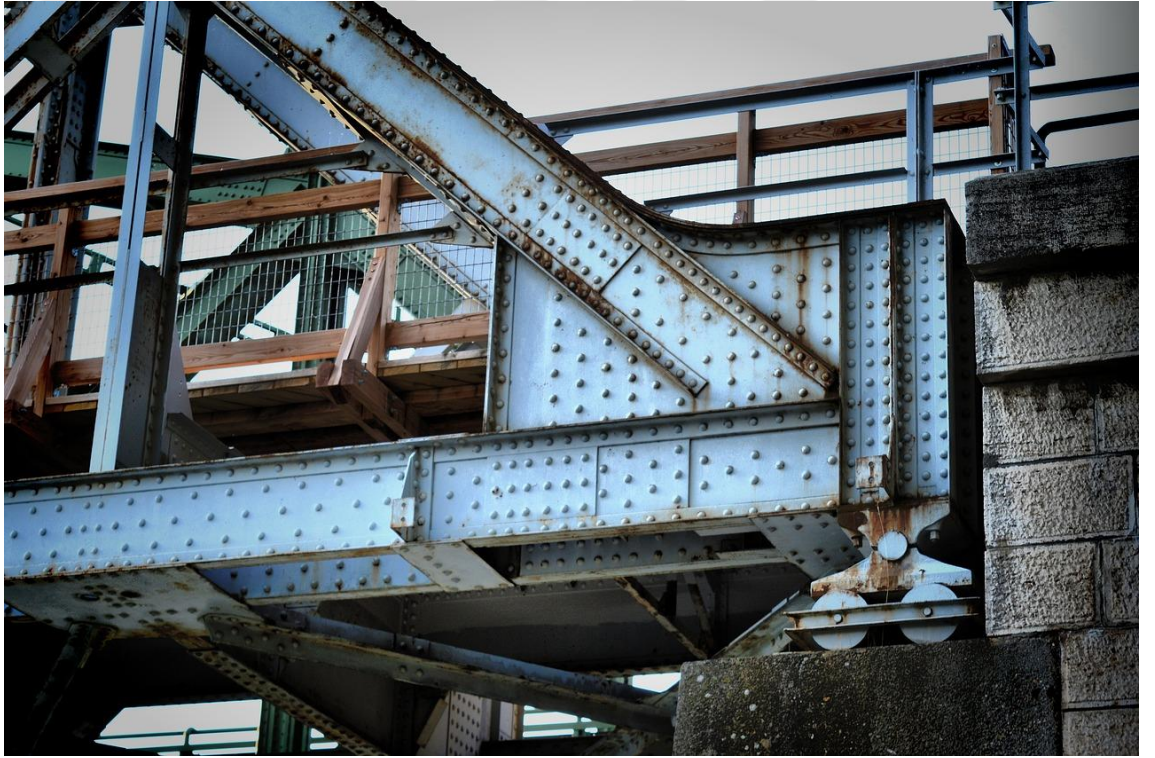
Şekil 1.4. Perçinli birleşimler
