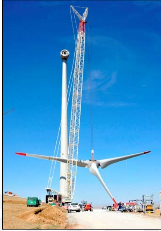
Şekil 23. Rüzgar Türbin Kurulumu [26]
