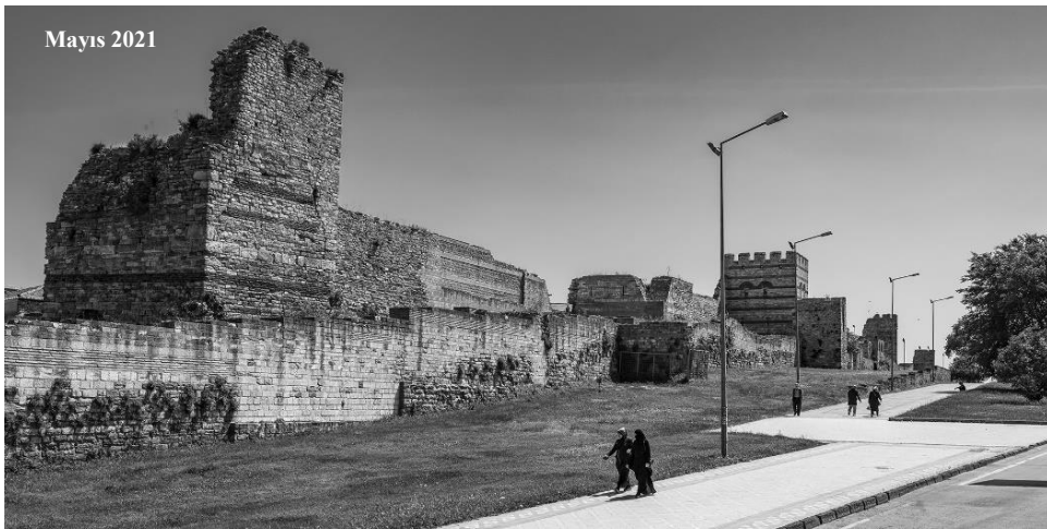
Görsel 73. İstanbul Surları_19. Topkapı surlarının güney yönüne doğru uzanışının dışarıdan görünümü.
