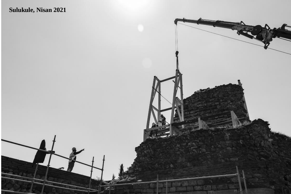
Görsel 161. İstanbul Surları_107. İBB Miras’ın 2020 yılında başlattığı restorasyon çalışmaları, ilk olarak yıkılma tehlikesindeki acil müdahale gerektiren kulelerin güvenliğini sağlamaya yönelik oldu.
