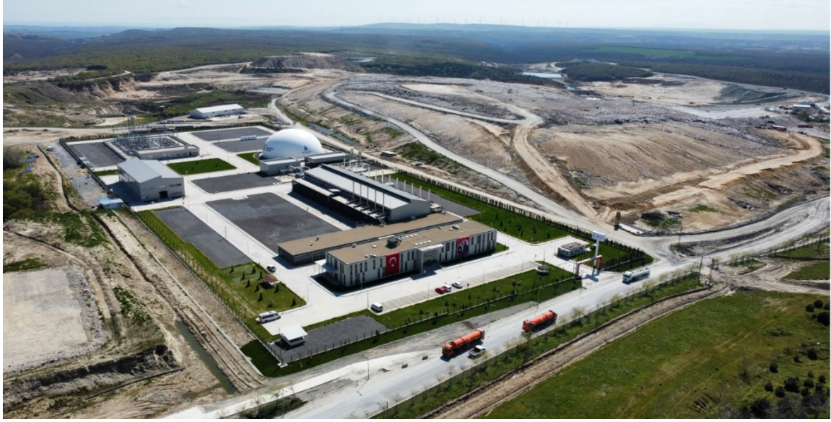
Şekil 2.14. Seymen çöp gazından elektrik üretim tesisi
