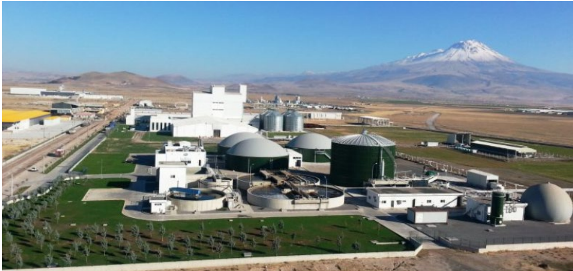
Şekil 2.10. Süttaş biyogaz ve elektrik üretim tesisi
