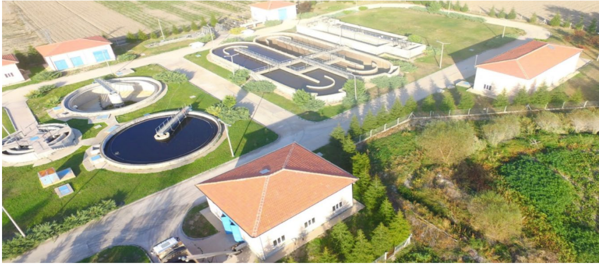
Şekil 2.11. Atık su arıtma tesisi
