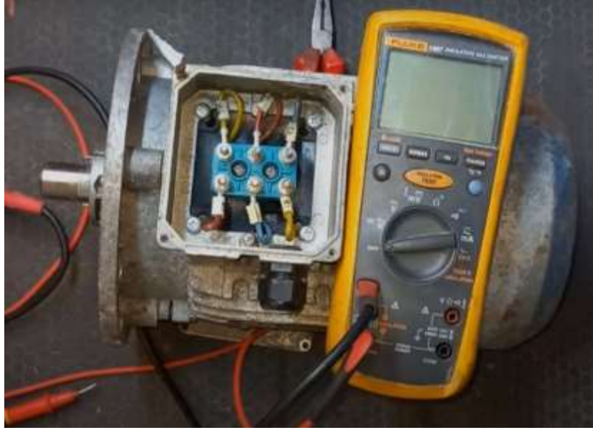
Şekil 3.10: Asenkron Motorun Klemens Kuplajı Sökülmüş – [Desan Tersanesi]
