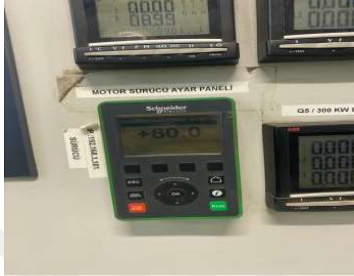
Şekil 3.18: Motora 60 Hz Frekans Uygulanması-[Desan Tersanesi]
