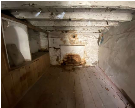
Fig. 49. Odanın kuzey duvarındaki ocak
