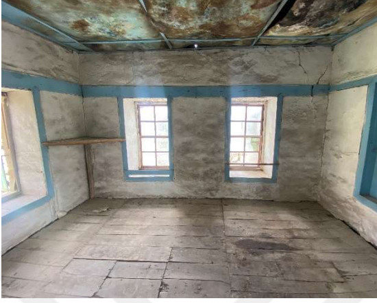
Fig. 37. Zemin döşemesi ve tavan
