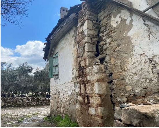
Fig. 21. Kuzey cephedeki ayrılma
