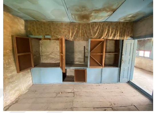
Fig. 24. Üst kattaki ahşap bozulmalar
