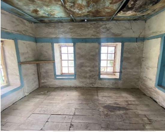
Fig. 17. Ü03 Odanın doğu cephesi
