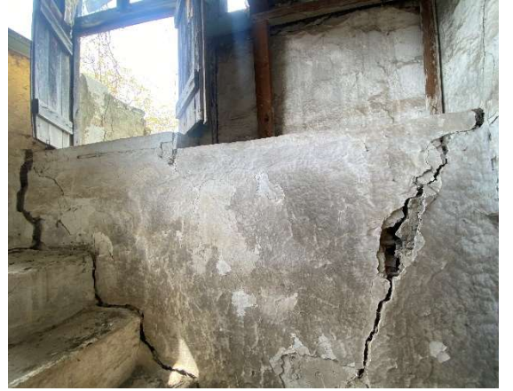
Fig. 22. Batı cephedeki ayrılma
