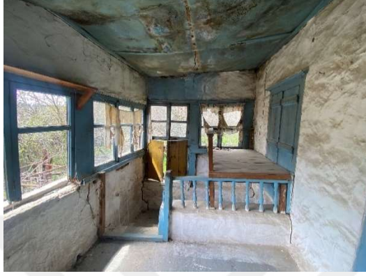
Fig. 23. Sofadaki ahşap bozulmalar
