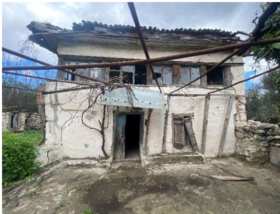
Fig. 25. Güney cephedeki kimyasal bozulma
