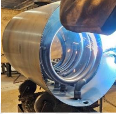
Şekil 3.13. Serpantin montaj işlemi
