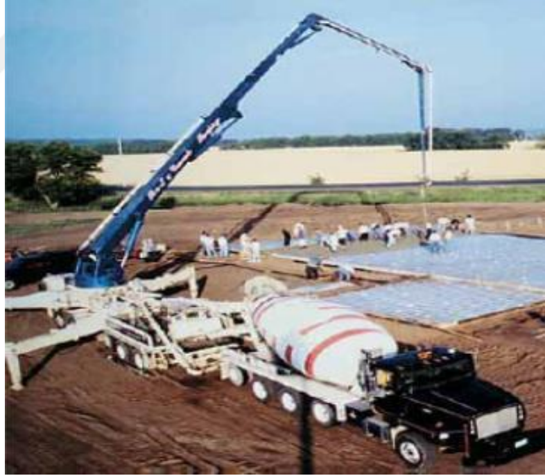
Şekil 2.12. Beton dökümü örneği [T.C. Millî Eğitim Bakanlığı, 2012].
