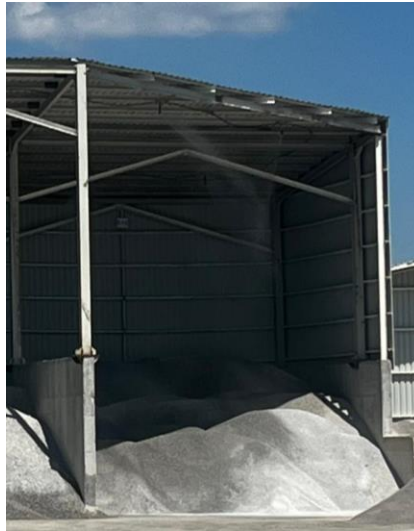
Şekil 3.10. Kapalı depolama alanında pülverize su sistemi kullanımı ( Z. Turan arşivi ).
