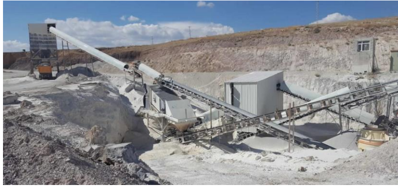
Şekil 3.2. Agregat üretim tesisi örneği [ Web 11,2024 ].
