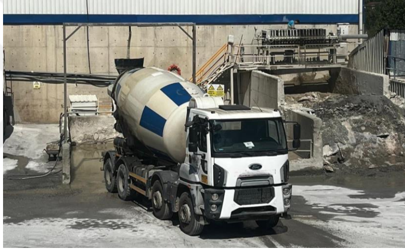
Şekil 2.13. Transmikser yıkama alanı örneği (Z. Turan arşivi).
