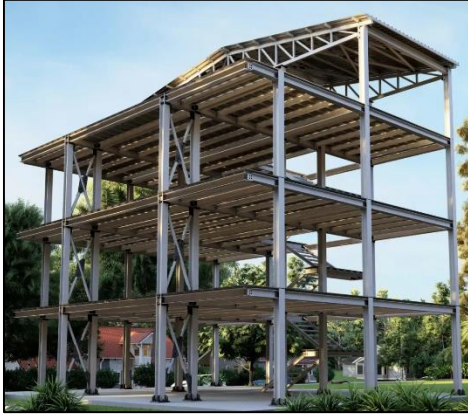
Resim 2.2. Ağır çelik taşıyıcıyla yapılmış konut karkası
