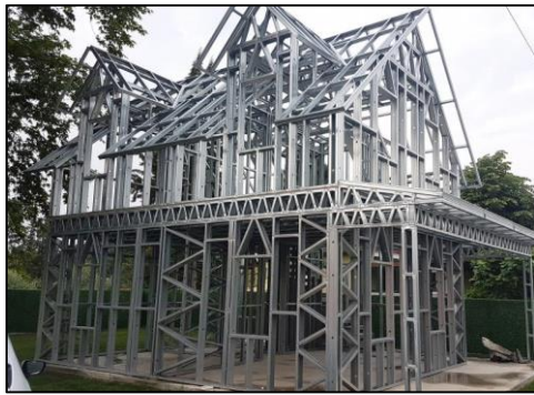
Resim 2.1. Hafif çelik taşıyıcıyla yapılmış konut karkası
