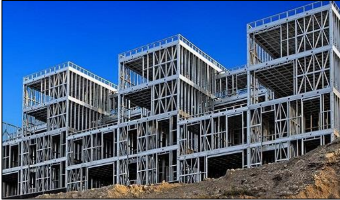
Resim 2.3. Modüler sistemle yapılmış konut karkası
