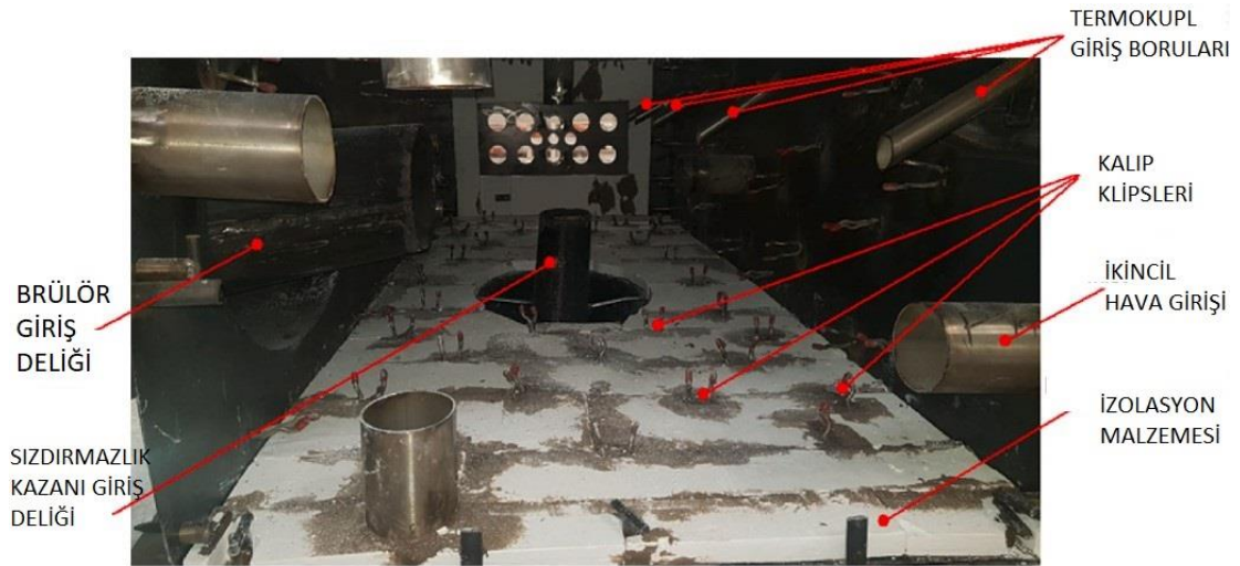
Şekil 4.3. Yanma odası kalıp izolasyon malzemesinin montaj görüntüsü
