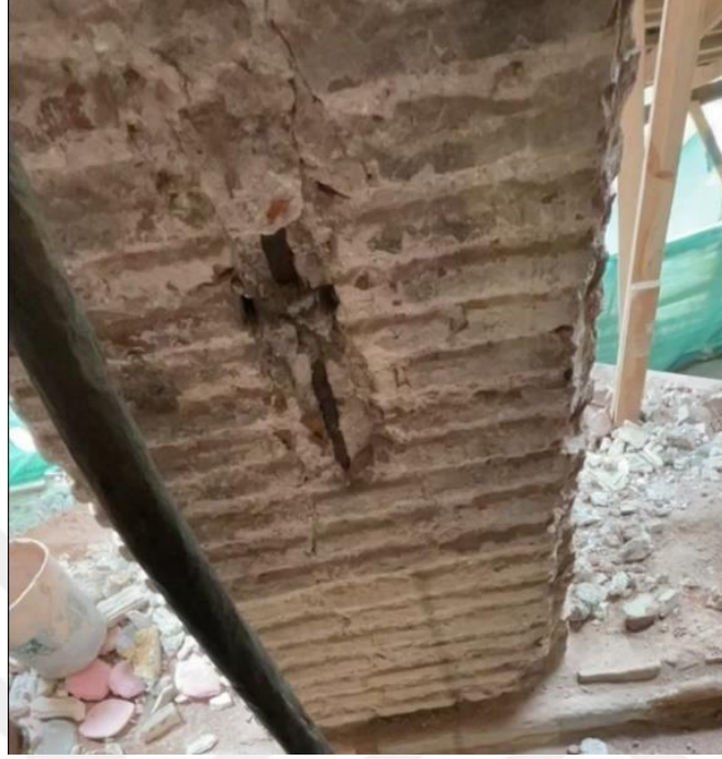
Şekil 4.71 Kubbe kasnak kotunda yer alan kılıçlama detayı
