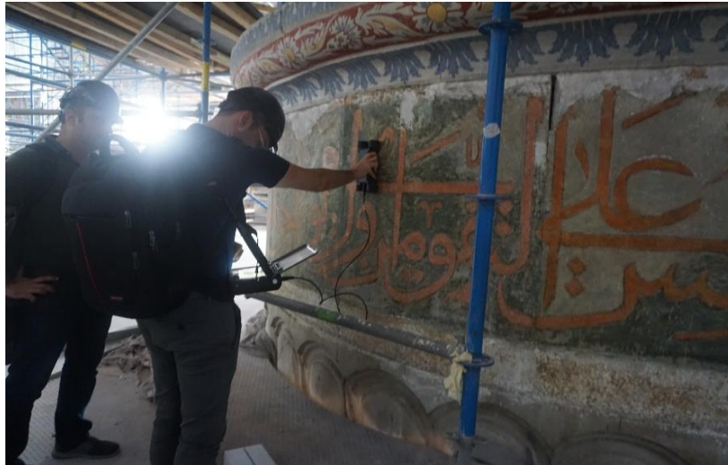
Şekil 4.43 Sultan Ahmet Camii fil ayağı manyetik indüksiyon yöntemi ile tespit çalışmaları
