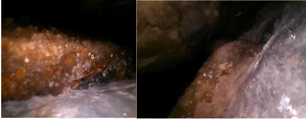
Şekil 4.74 Fil ayağında tespit edilen demirin videoskop görüntüleri
