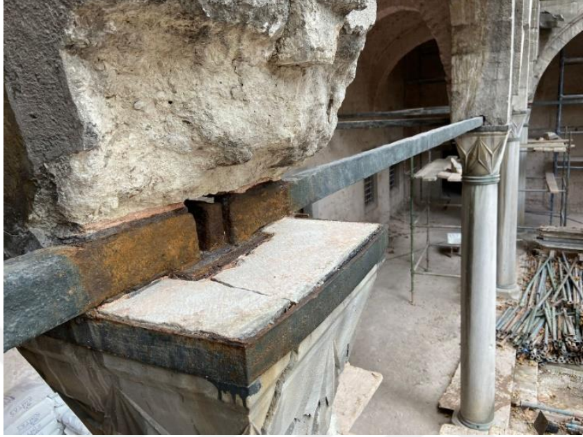
Şekil 4.65 Süleymaniye İmaret revaklı avlu sütün başı gergi mesnet detayı
