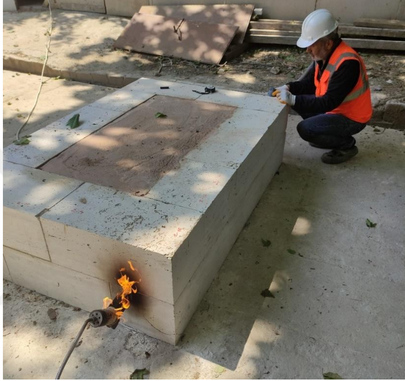
Şekil 4.58 Özgün gergi demirinin ısıtılması
