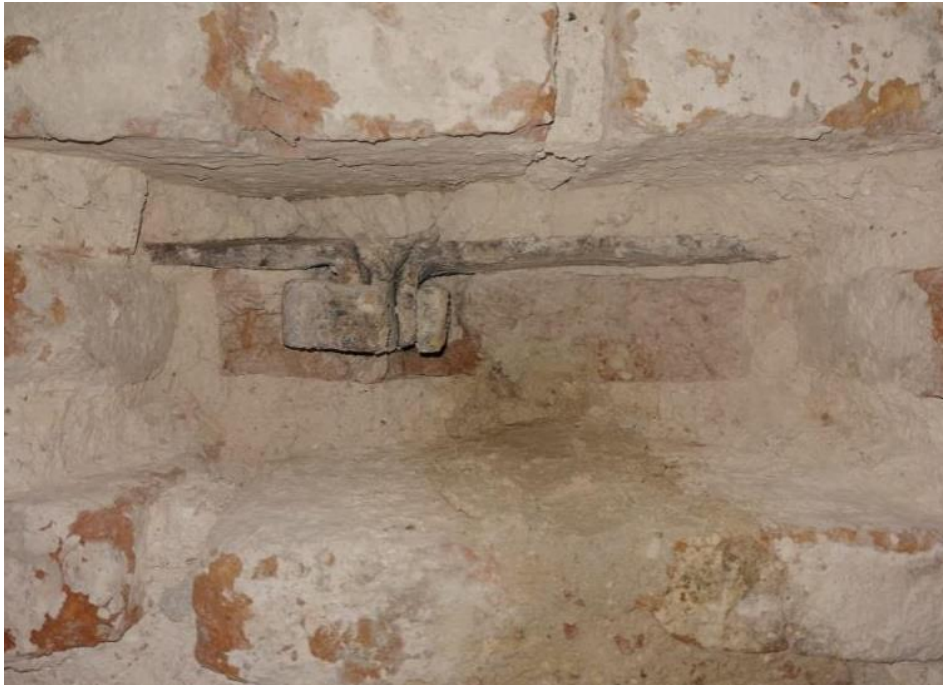
Şekil 2.12 Sultan Ahmet Camii kubbe kuşaklaması simid detayı
