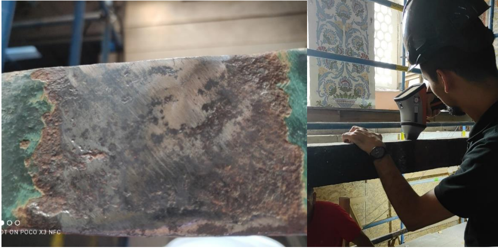
Şekil 4.79 a) Gergi yüzeyinin boya ve pas tabaksından arındırılması b) Gergi elemanı üzerinde XRF ölçümü
