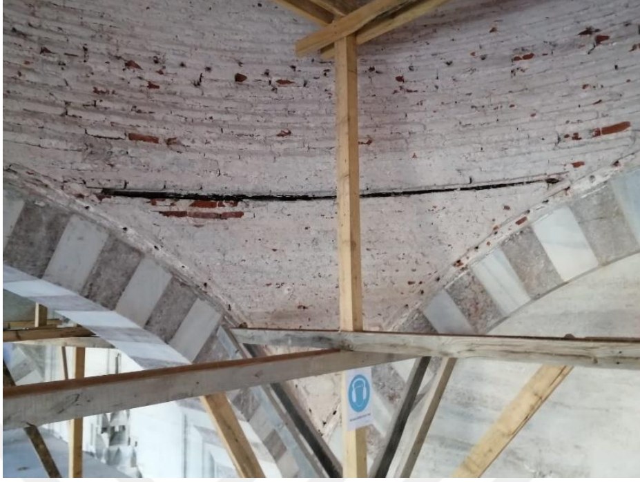
Şekil 4.45 Sultan Ahmet Camii revaklı avlu kubbesinde yer alan demir elemanı
