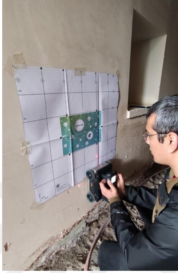
Şekil 4.40 Karadeniz Medresesi demir kılıçlamaların üç boyutlu radar ölçümü ile tespiti
