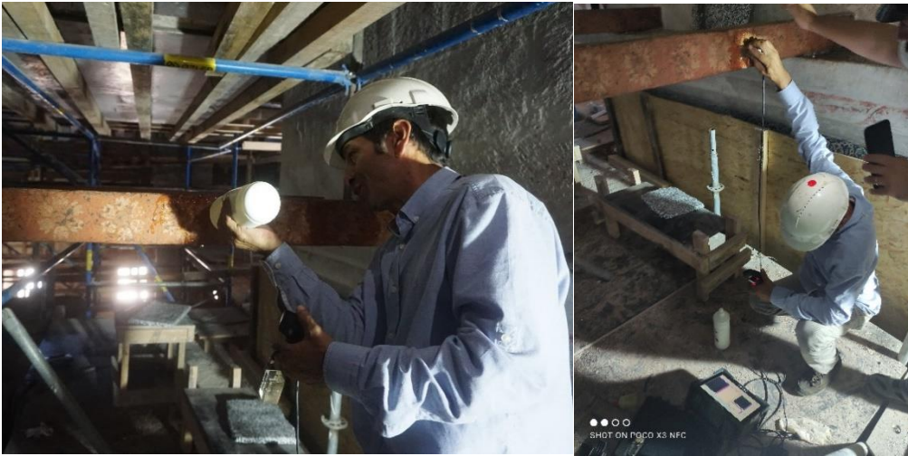
Şekil 4.82 Sultan Ahmet Camii gergilerinde phased array cihazı ile süreksizliklerin araştırılması
