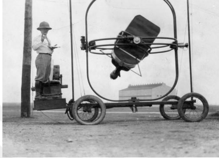
Fotoğraf 1.4. Ruggles Orientator (Anonim, Haziran 2017)
