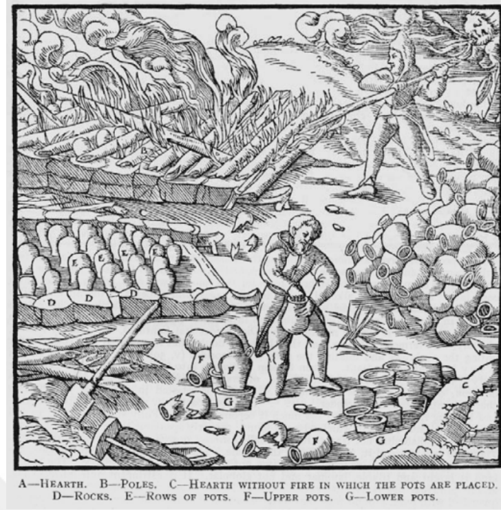
Şekil 2.3-2 Açık ocakta zincifre cevherinden cıva çıkarımı tasviri (Parsons and Percival, 2005).
