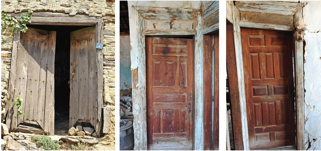
Fotoğraf 351-353: Zemin Kat ve Oda Kapılarının Görüntüleri
