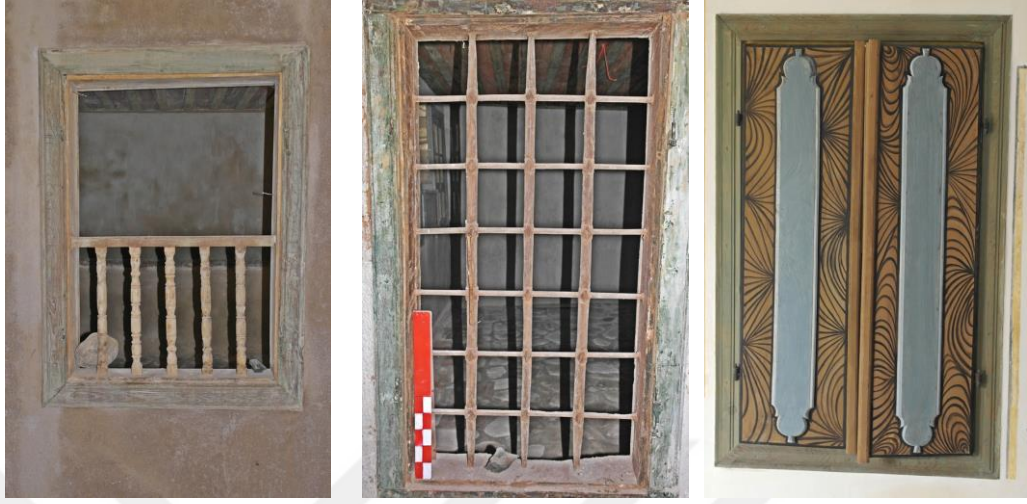
Fotoğraf 32-34: Tornalı, Kavelalı Geçme Korkuluklar ve Pencere Kapağı Görüntüsü
