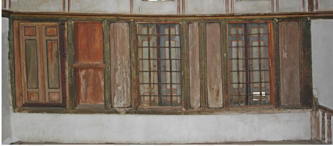
Fotoğraf 137: Batı Kanadı Dolap, Raflı Göz, Pano, Korkuluk ve Pencere Kapakları Görüntüsü
