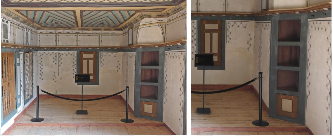
Fotoğraf 40 ve 41: Güney-Doğu Eyvanı Dolap ve Raflı Göz Elemanlarının Görüntüleri
