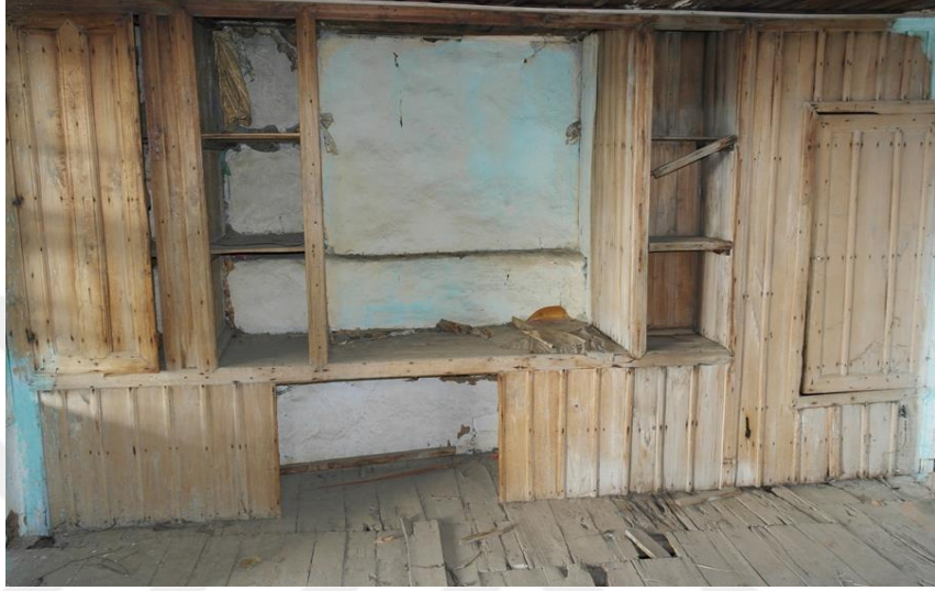
Fotoğraf 166: Yüklük, Gusülhane, Dolap ve Raflı Gözlerden Oluşan Birimin Görüntüsü
