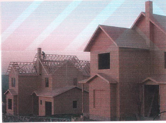
Resim 3.25 Makas çatı sistemlerinde farklı çözümler
