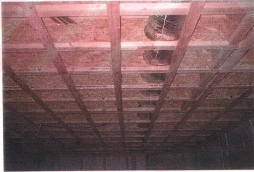
Resim 3.20. Ahşap yapıda I kiriş uygulaması.
