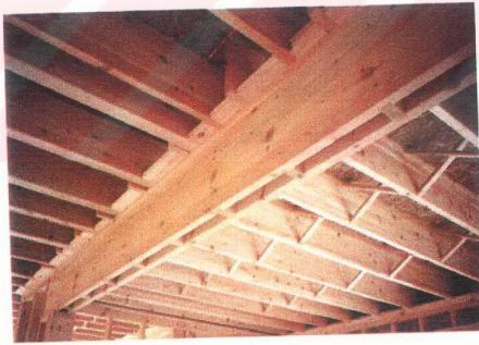
Resim 3.21 Tabakalı kirişlerden oluşan ahşap döşeme sistemi
