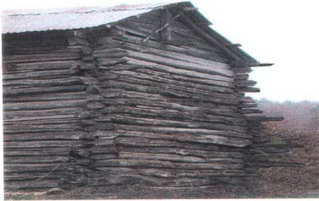
Resim 3.5. Geleneksel yapım yöntemi “Kurtboğaz Yöntemi” ile inşa edilen yapı [Web 4]
