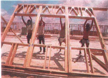
Resim 3.16 Ahşap platform çerçeve yapıda dış duvarlar
