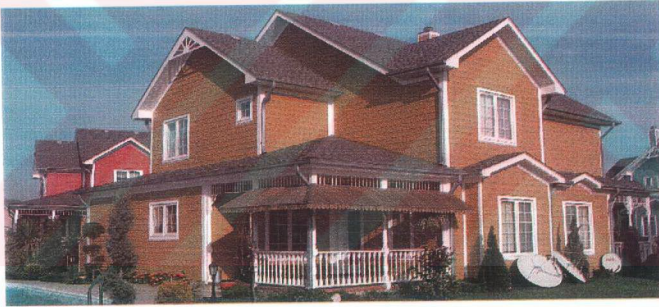
Resim 3.15 Dış kaplaması tamamlanmış ahşap platform çerçeve yapı
