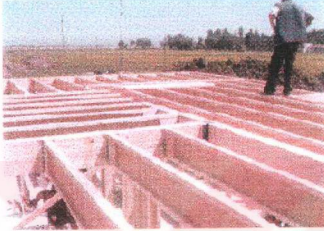
Yapılarda döşeme montajı
