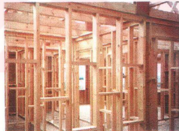
Resim 3.17 Ahşap platform çerçeve yapıda iç duvarlar
