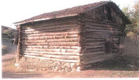
Resim 3.4. Geleneksel yapım yöntemi “Karaboğaz Yöntemi” ile inşa edilen yapı [Web 4]
