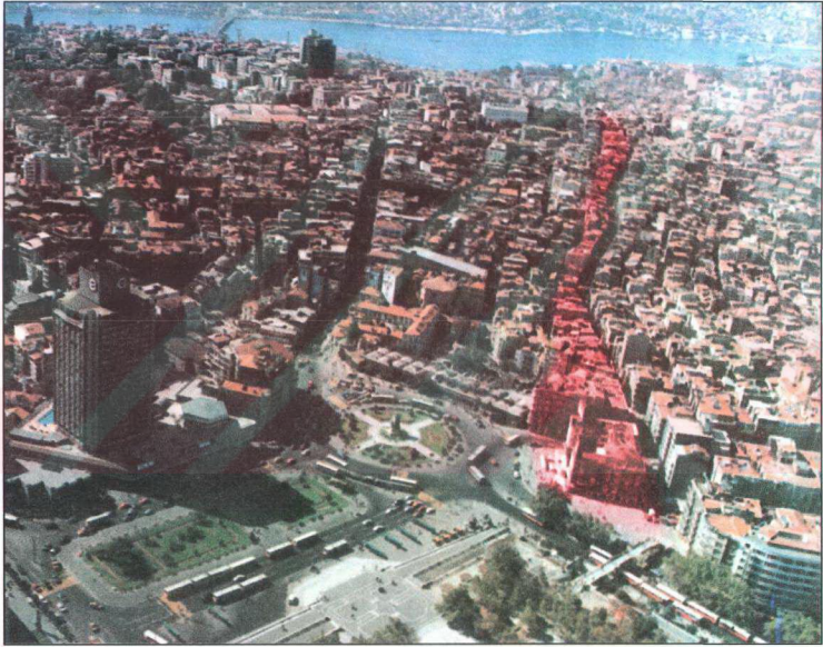
Şekil 4.9. Tarlabaşı Caddesi Yıkımı Yapılan Binalar
