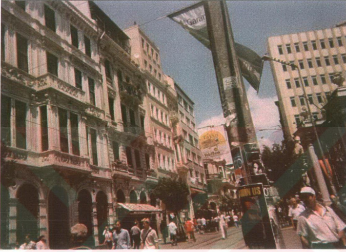
Resim 4.1. Beyoğlu Postane Hizmet Binası
