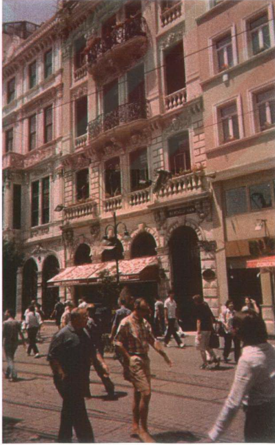
Resim 4.9. Beyoğlu Han Binası
