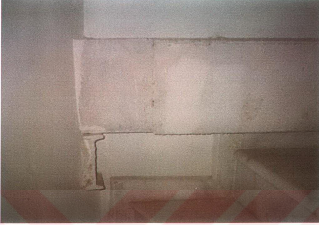
Resim 4.7. Üçüncü normal katta merdiven kovası için volta döşemede yapılan tadilat
