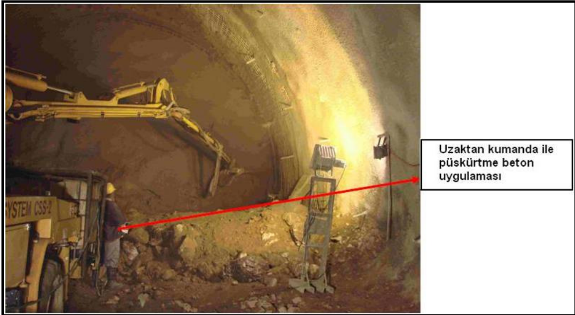
Şekil 3.2 Püskürtme beton uygulamasını gösteren bir fotoğraf.
