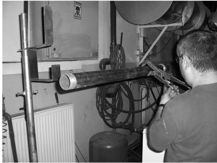
Şekil 4.11 : Boru malzemesi montajı
