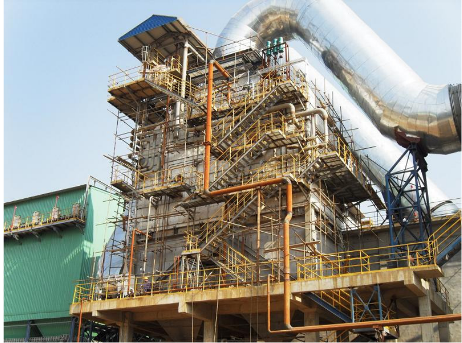
Şekil3.9 AQC Kazanı Yapısal Görünümü
