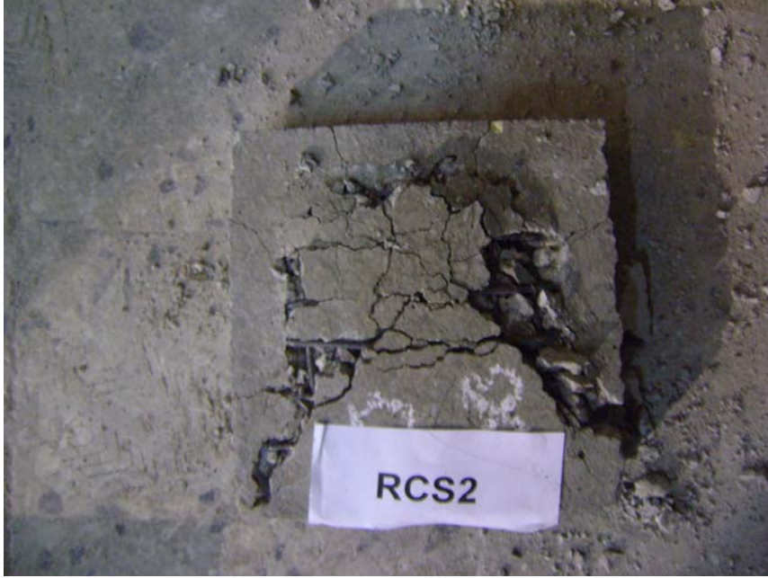
Őekil 3.17. RCS 2 numunesinin atlak dađılımı
