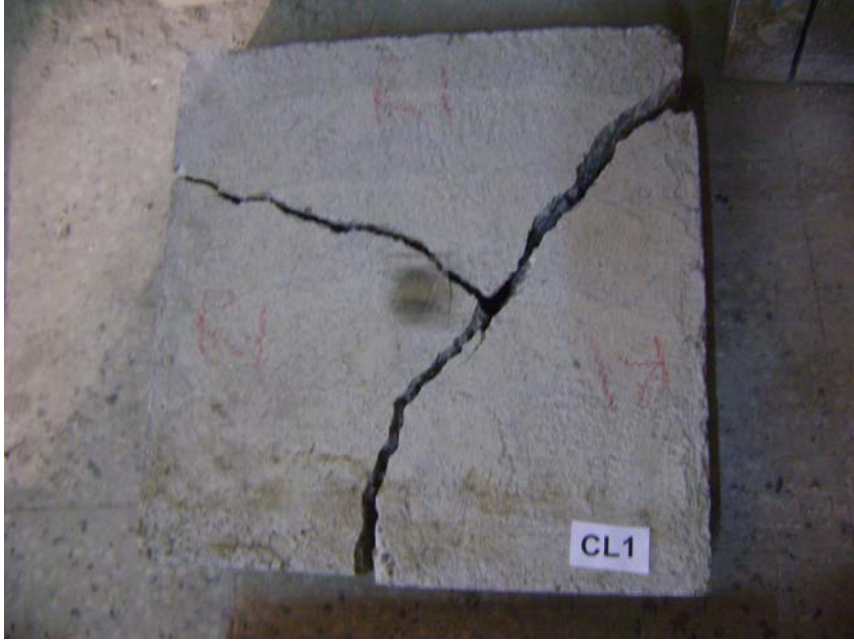
Şekil 3.1. CL 1 numunesinin çatlak dağılımı
