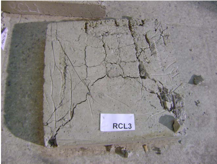
Şekil 3.12. RCL 3 numunesinin atlak dađılımı
