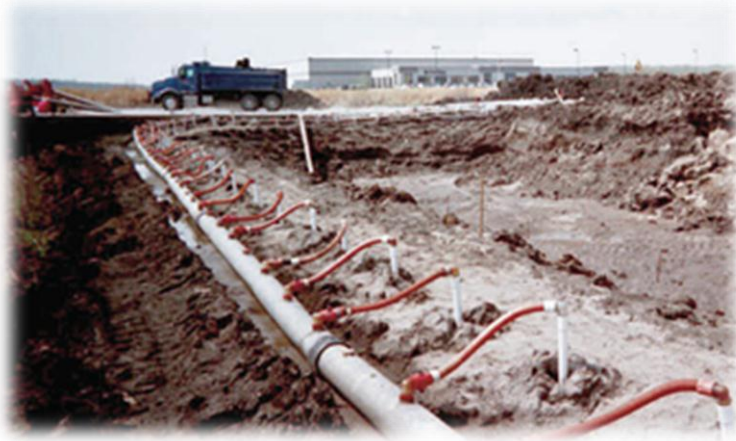
Şekil 2.4: Hidrolik iyileştirme (wellpoint uygulaması)
