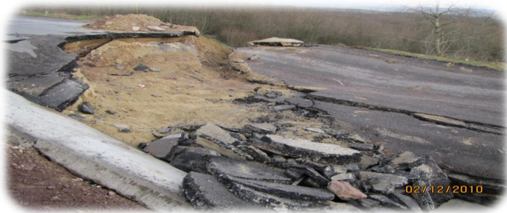
Şekil 2.2: Uzunçiftlik civarında çökmüş bir yol
