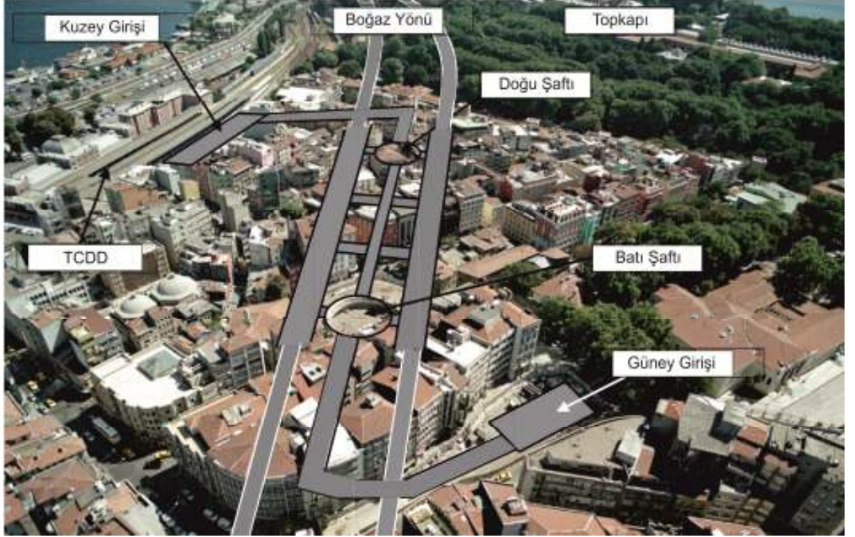
Şekil 1.4: Sirkeci istasyonu tünelleri havadan görüntüsü
