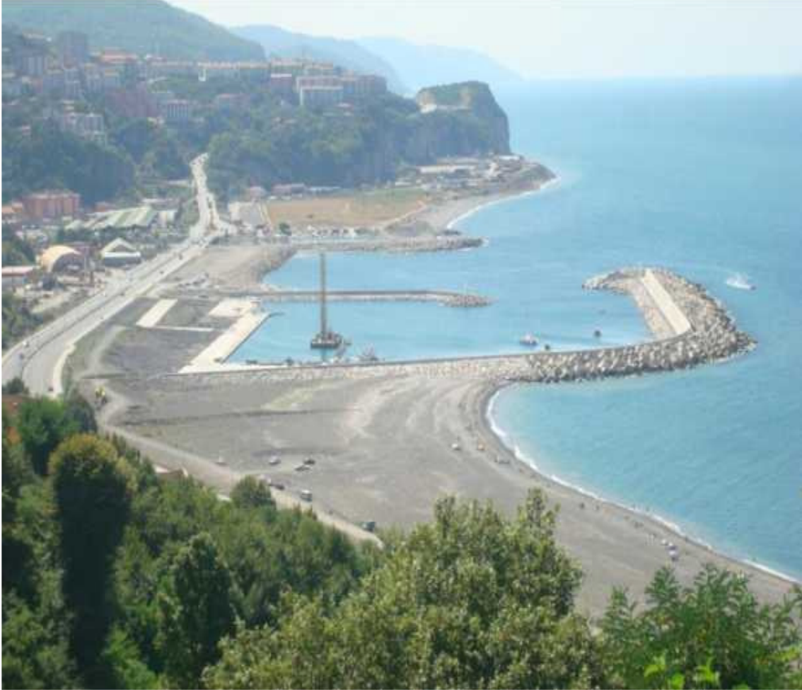
Şekil 5.7 Kozlu balıkçı barınağı
