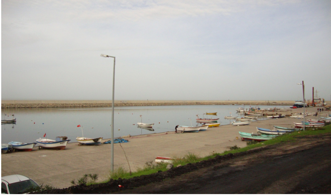
Şekil 5.3 Alaplı Balıkçı Barınağı
