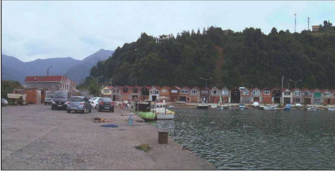
Şekil 3.1 Balıkçı Barınakları Kaçak Yapılaşma Örneği
