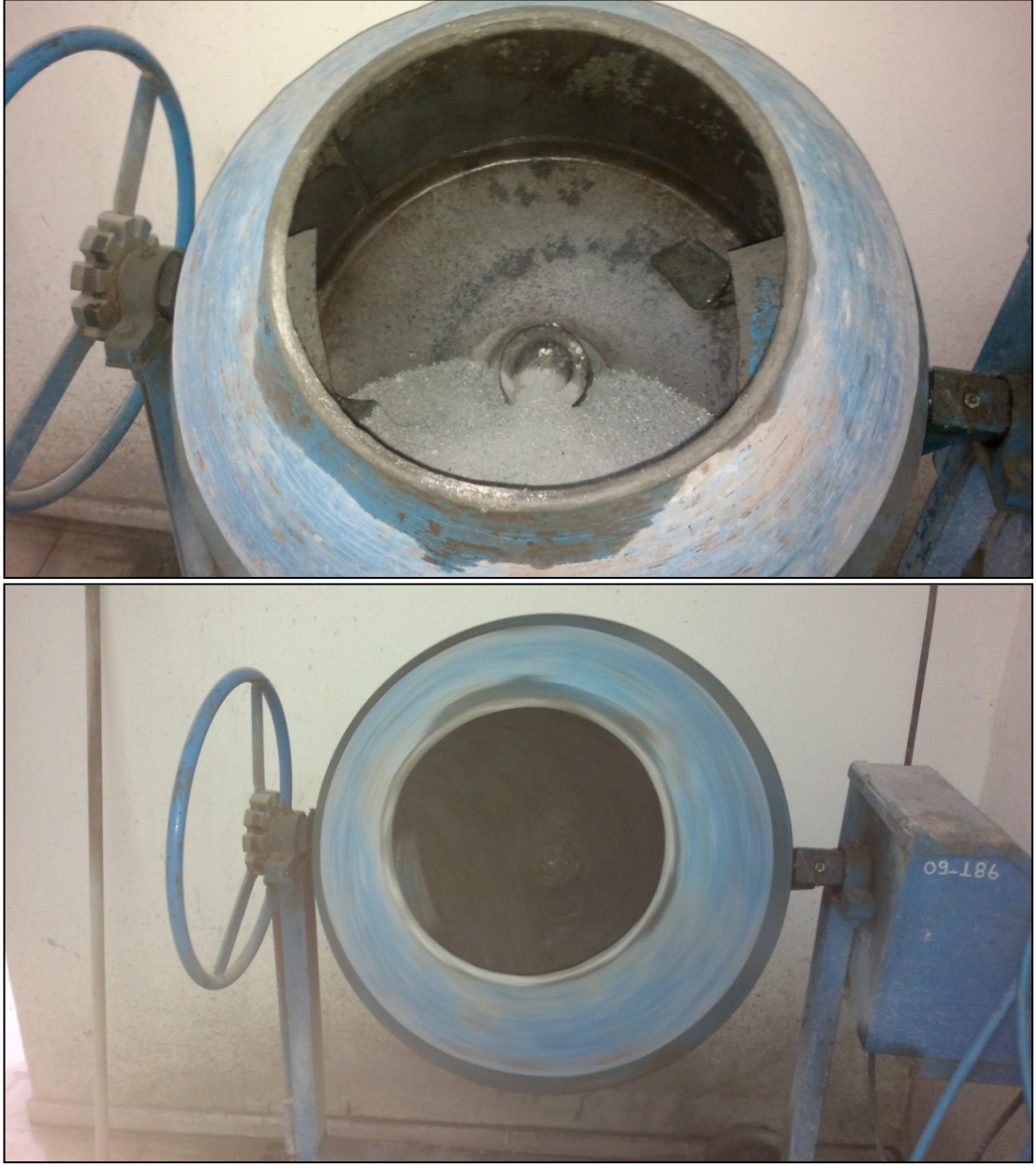
Ŗekil 29. Beton üretimi
