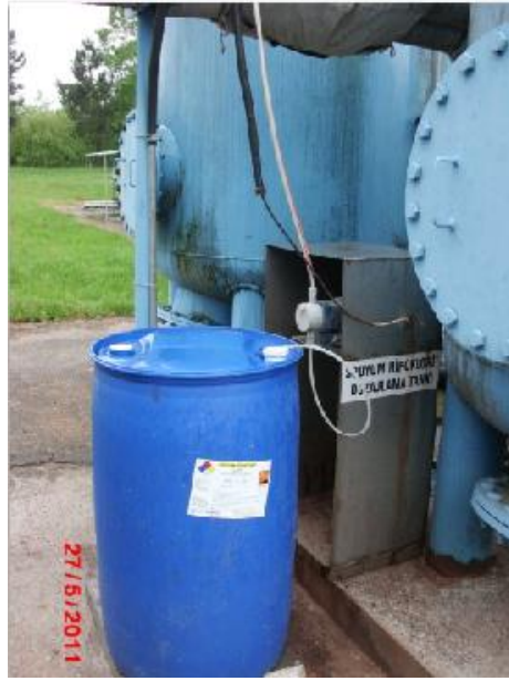
Şekil 5.3: Ön arıtmada sodyum hipoklorit dozajı
