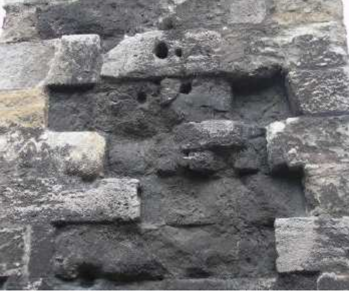
Şekil 31. Anıtta GB cephesinde kullanılmış killi kalker taşı (Tulgar, 2007)
