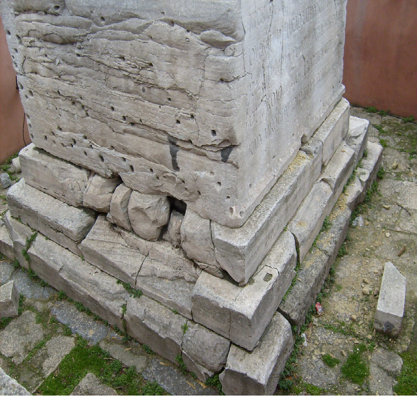
Şekil 26. Örme Dikilitaş'ın Temel Yapısında Kullanılan Mermer
