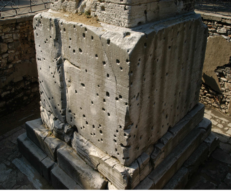
Şekil. 107. Örme Dikilitaş'ın Doğal Sismik İzolatör İşlevi Yapan Temel Kısmı
