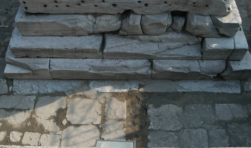
Şekil 110. Örme Dikilitaş'ın Doğal Sismik İzolatör İşlevi Yapan Temel Kısmı
