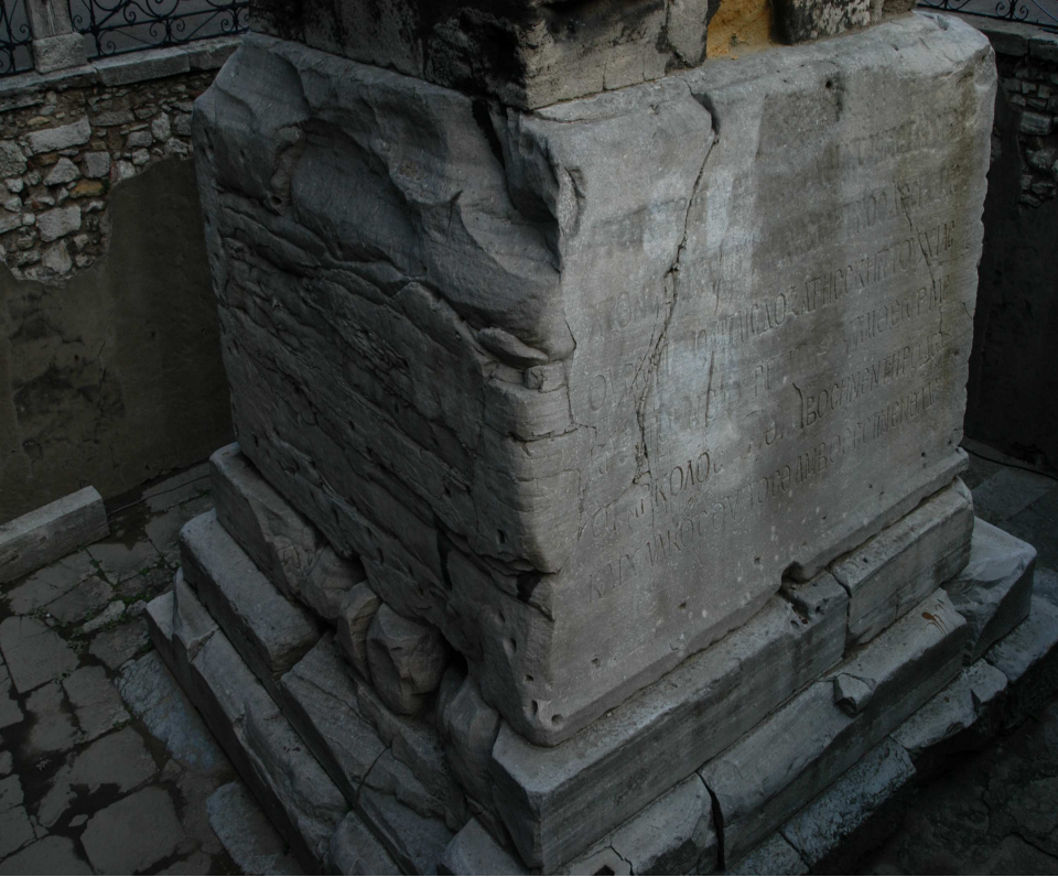
Şekil 108. Örme Dikilitaş'ın Doğal Sismik İzolatör İşlevi Yapan Temel Kısmı
