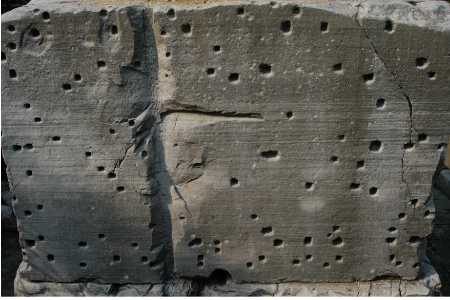
Şekil 105. Örne Dikilitaş'ın Doğal Sismik İzolatör İşlevi Yapan Temel Kısmı
