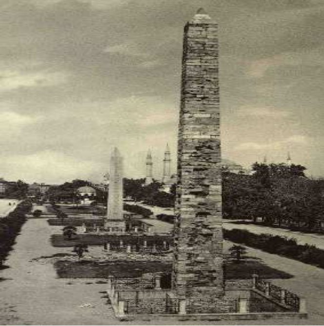
Şekil 22. Sultanahmet Örne Dikilitaş'ının eski yıllara ait görünümü Başgelen,Ousterhout, 2005:33 (Tulgar, 2007)
