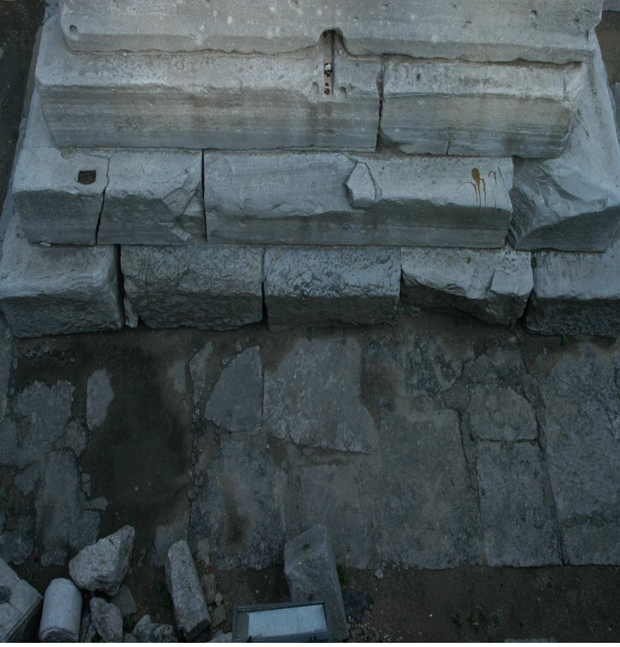
Şekil 111. Örne Dikilitaş'ın Doğal Sismik İzolatör İşlevi Yapan Temel Kısım
