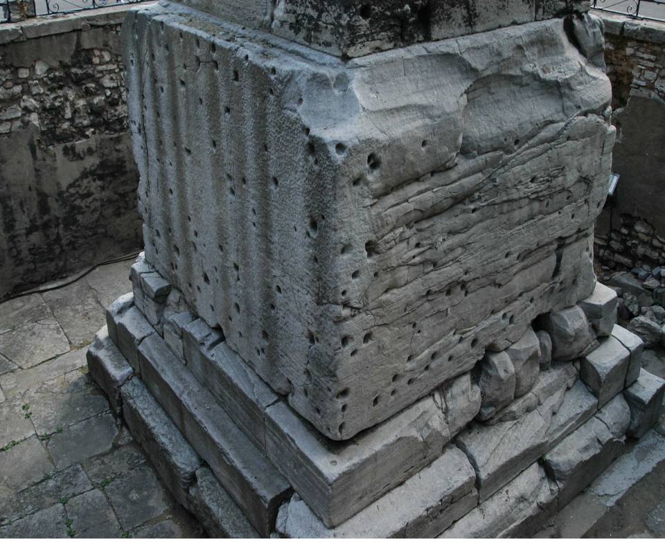
Şekil 109. Örme Dikilitaş'ın Doğal Sismik İzolatör İşlevi Yapan Temel Kısmı
