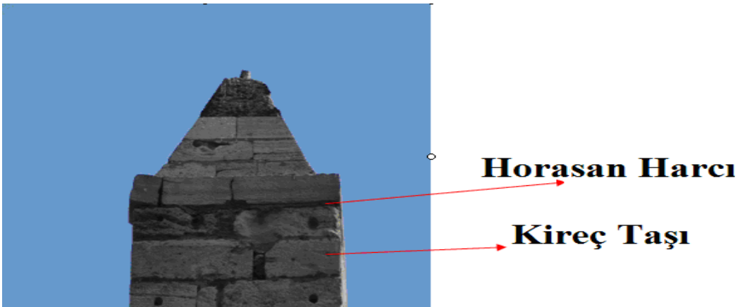
Şekil 24. Örme Dikilitaş'ın Üst Yapısı
