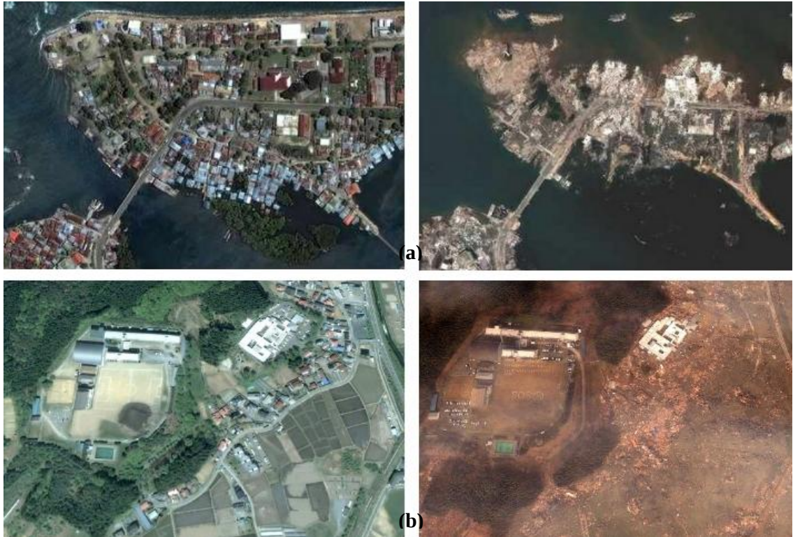
Şekil 1.1 Tsunami öncesi ve sonrası uydu görüntüleri; (a) Aceh, Sumatra, 2004, (b) Minamisanriku, Japonya, 2011
