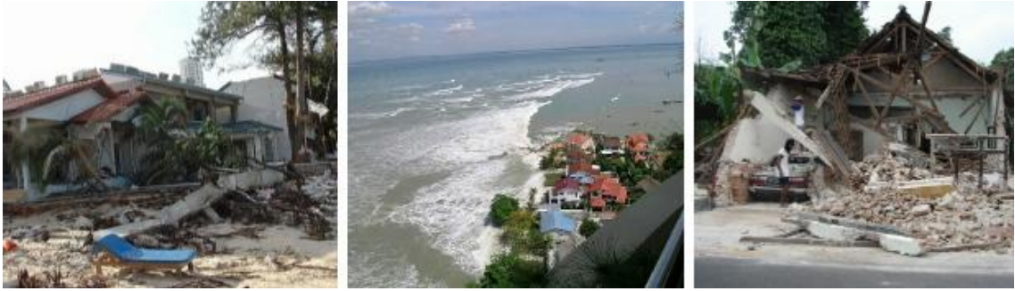
Şekil 6.3 Tsunami sonrası Malezya kıyılarındaki hasar
