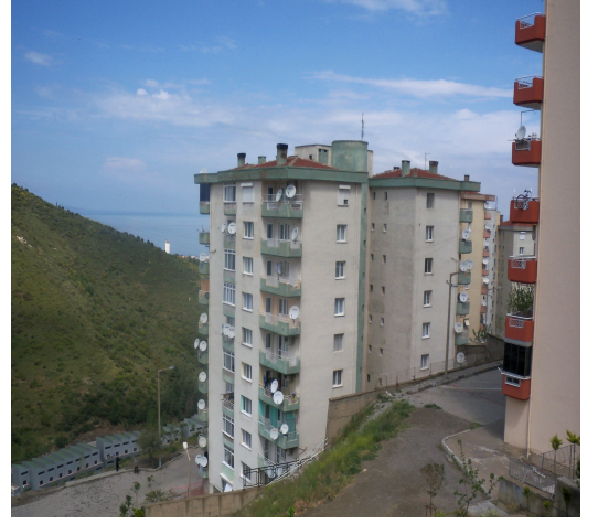
Bloklar oldukça eğimli bir bölgeye inşa edilmiş
