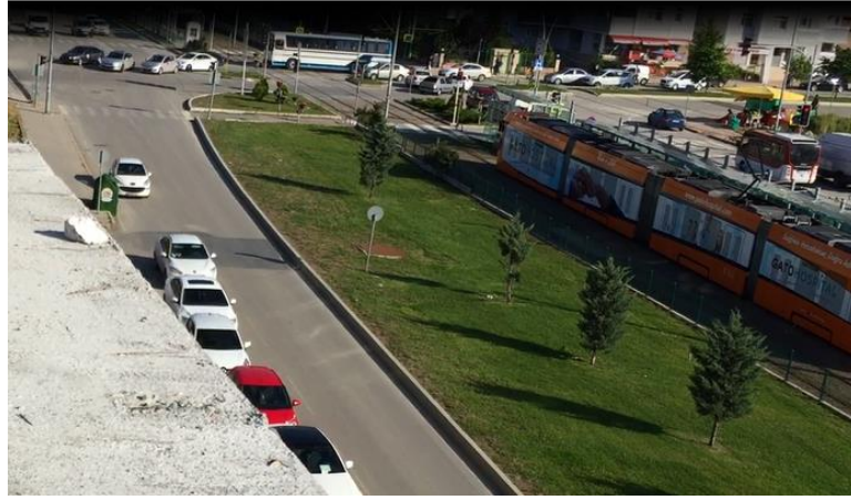
Şekil 4.27: Yenimahalle hemzemin geçidi kamera görüntüsü
