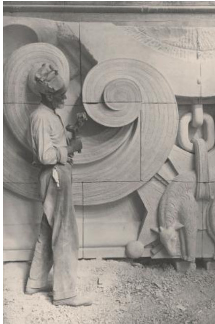
Şekil 4.75. Dış cephede bulunan süslemelerden biri (Espacio Fundación Telefónica broşürü)
