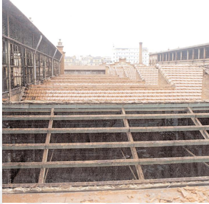
Şekil.4.152. Çatının restorasyon sürecindeki yenilenmesi (Fundacion COAM mimarlık yayını)
