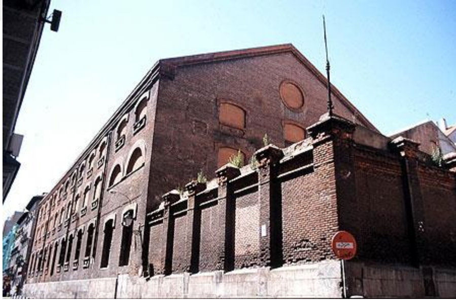
Şekil 4.38. Binanın, yeniden işlev kazandırılmadan önceki durumu (www.madrimasd.org)
