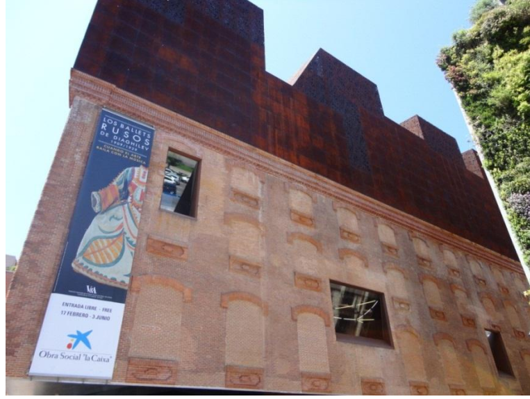
Şekil 4.40. Pencere açıklıklarının tuğlaların örülmesi ile oluşan yeni cephe (Zeynep Fırat arşivi)
