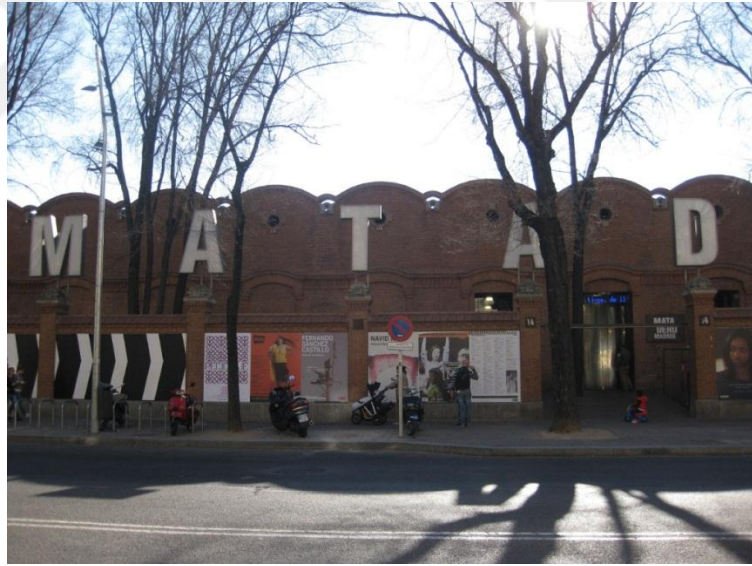
Şekil.4.149. Matadero Madrid binasına Paseo de la Chopera'dan giriş (http://buildipedia.com)
