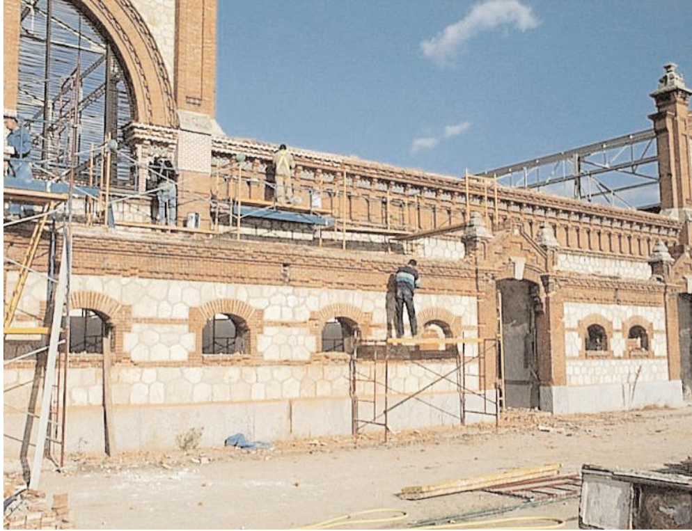
Şekil.4.157. Dış cephenin yenilenme süreci ( Fundacion COAM mimarlık yayını)
