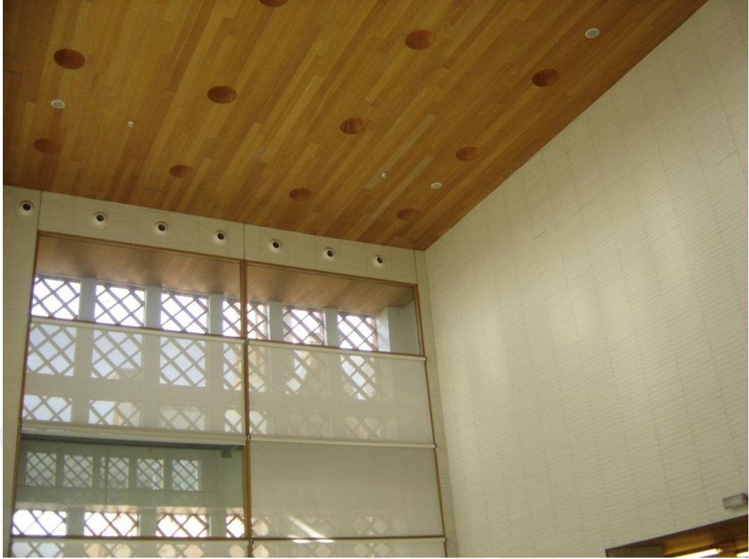
Şekil 4.132. İç cephede duvar ve tavan kaplaması (Alejandro Valdivieso Royo arşivi)
