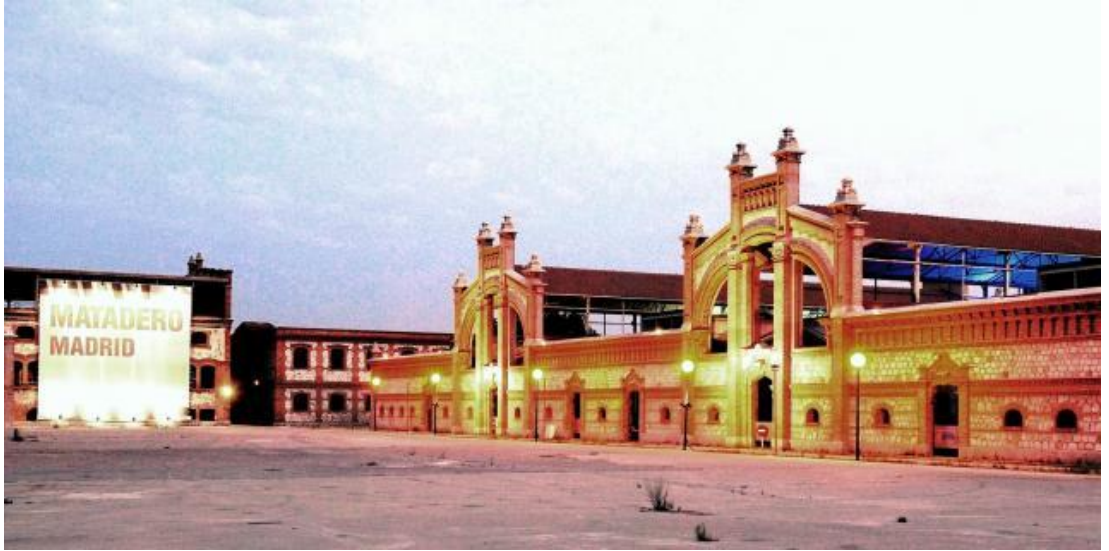
Şekil 2.3. İspanya'nın Madrid kentinde bulunan Matadero binası (www.transartists.org)
