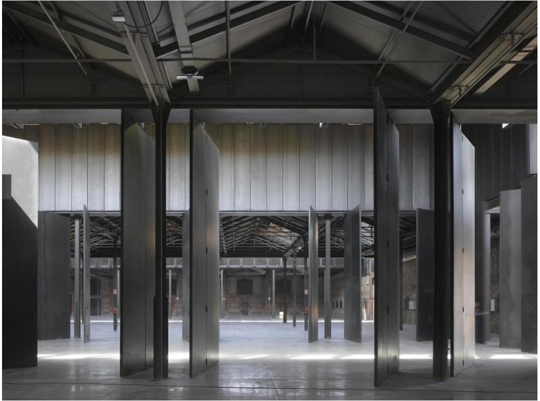
Şekil.4.175. Tesisin genel görünümü ( www.inaquicarnicero.com )
