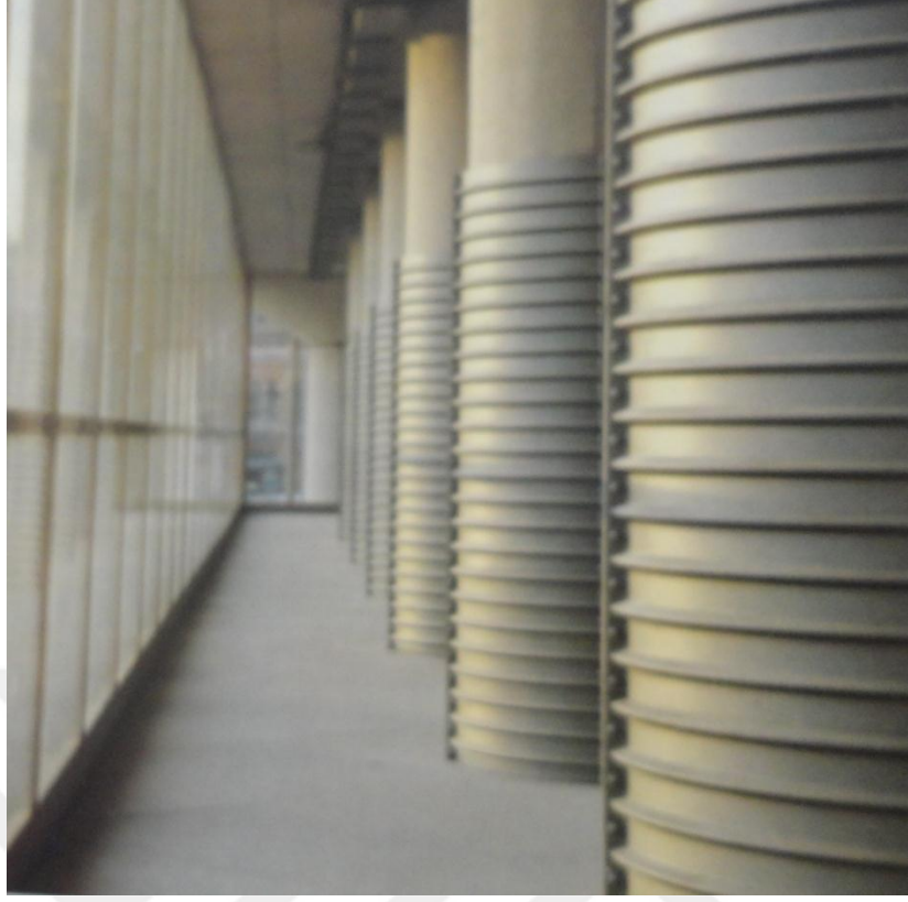
Şekil 4.23. Yeni terminalde bulunan kolonlar (A&V 1992 yayını)
