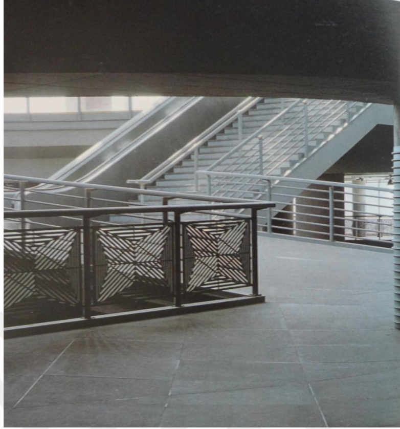
Şekil 4.21. Yeni terminalin iç mekanında bulunan yürüme yolları ve merdivenler (A&V 1992 yayını)
