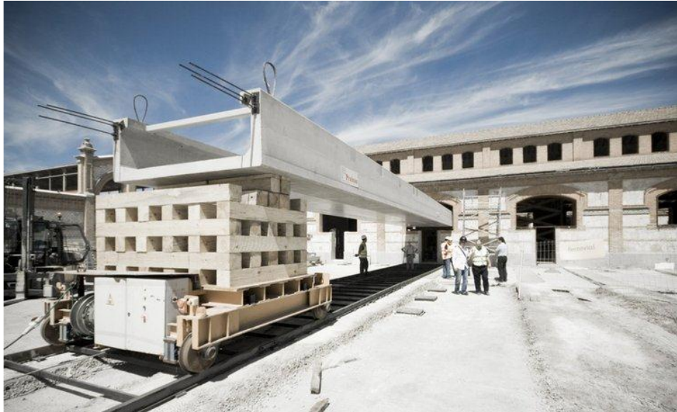
Şekil.4.170. Yapının inşasında, 24 metre. uzunluğunda ve 53 ton ağırlığında kullanılan 11 adet kiriş, pnömatik ray sistem ile yerleştirilmiştir ( www.ensamble.info )
