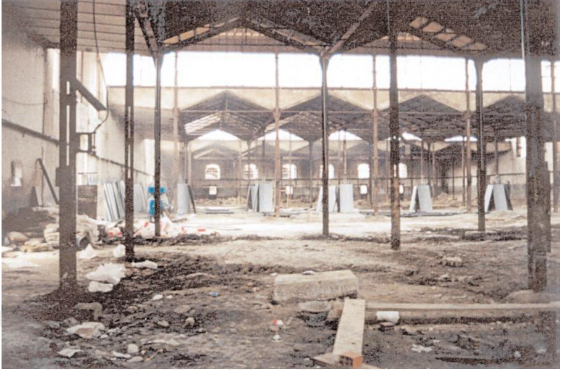
Şekil.4.154. Matadero Madrid'in içerisinde bulunan bir tesisin restorasyon süreci (Fundacion COAM mimarlık yayını)
