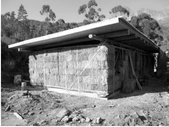
Resim 1.14. Güney Afrika'da Saman Balyalarının Duvar Elemanı Olarak Kullanımına Ait Görünümler (Bruehlisauer, 2007).
