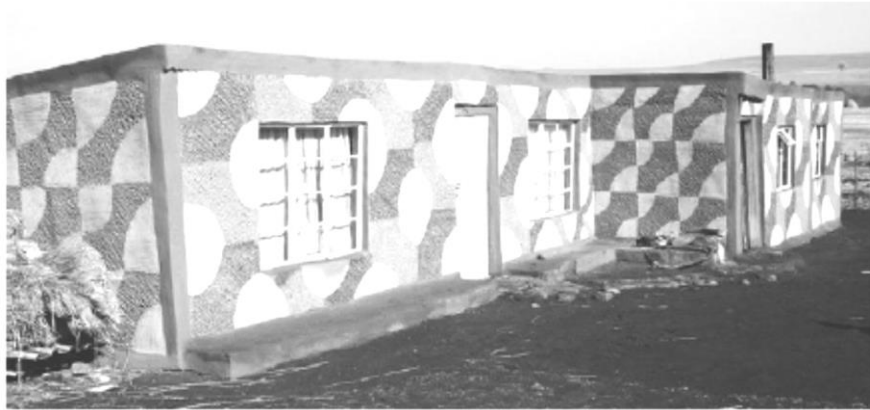
Resim 1.15. Gana'da Bulunan Kerpiçten Yapılmış Ev ve Dış Duvarlarına Ait Görünümler (Bosman ve Van Der Westhuizen, 2014).
