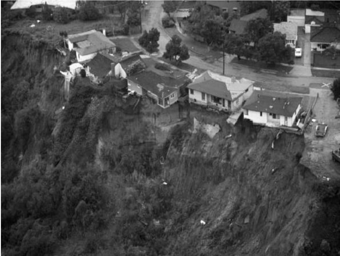
Şekil 2.1 : Zeminde meydana gelen göçme örneği (Budhu, 2011)
