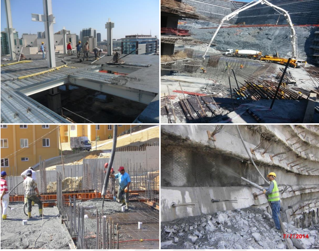
Şekil 2.1 Beton uygulamalarından örnekler
