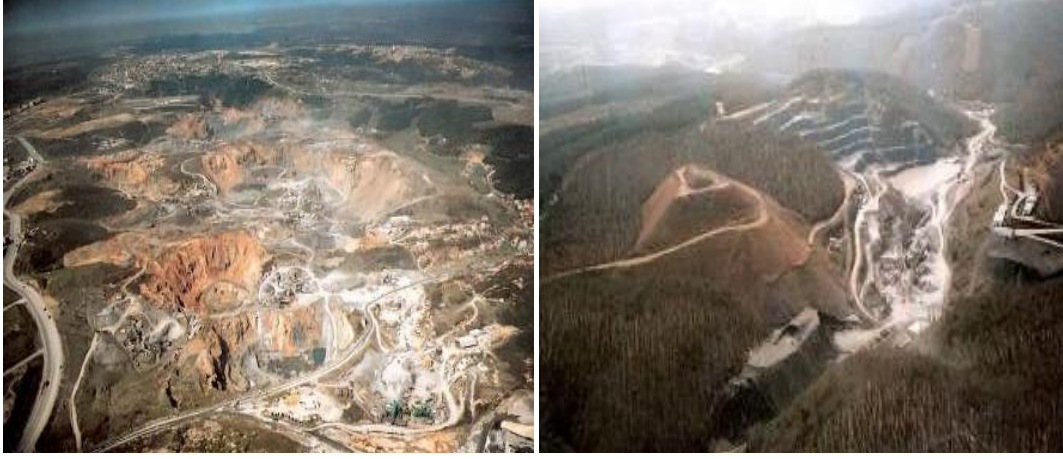
Şekil 2.5 Agregat işletmelerinden örnekler
