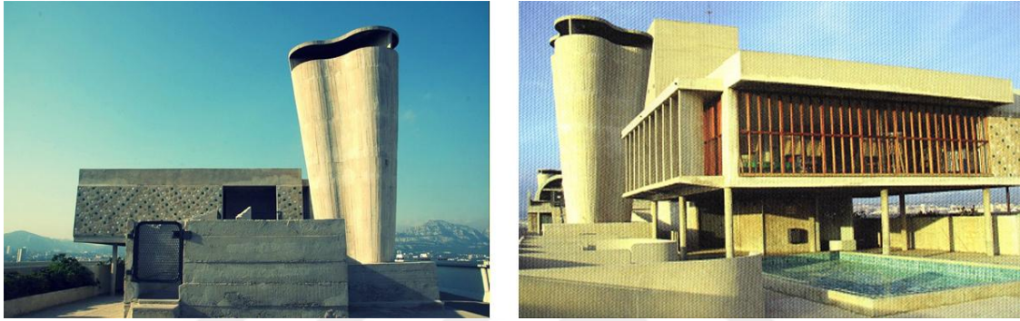
Şekil 3.2 Unite d'Habitationin Heykelsi Çatısı [49]
