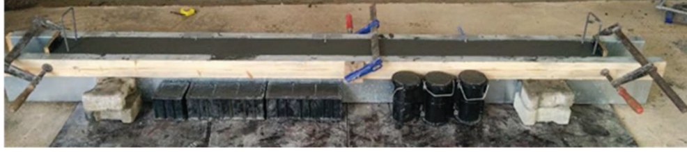
Şekil 2.20: Dökümü tamamlanmış test kirişi
