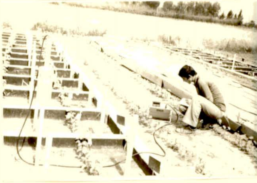
Şekil 3.17 Lizimetre tanklarında nütrometre ile nem kapsamının belirlenmesi
