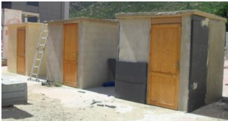
Şekil 3.4: Model binalarda sıva ve izolasyon aşamaları
