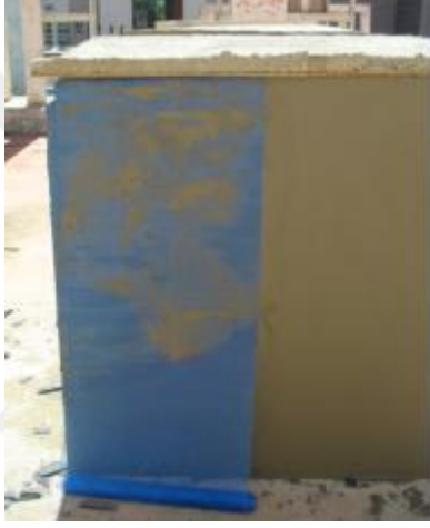
Şekil 3.5: Model binalarda izolasyon uygulaması
